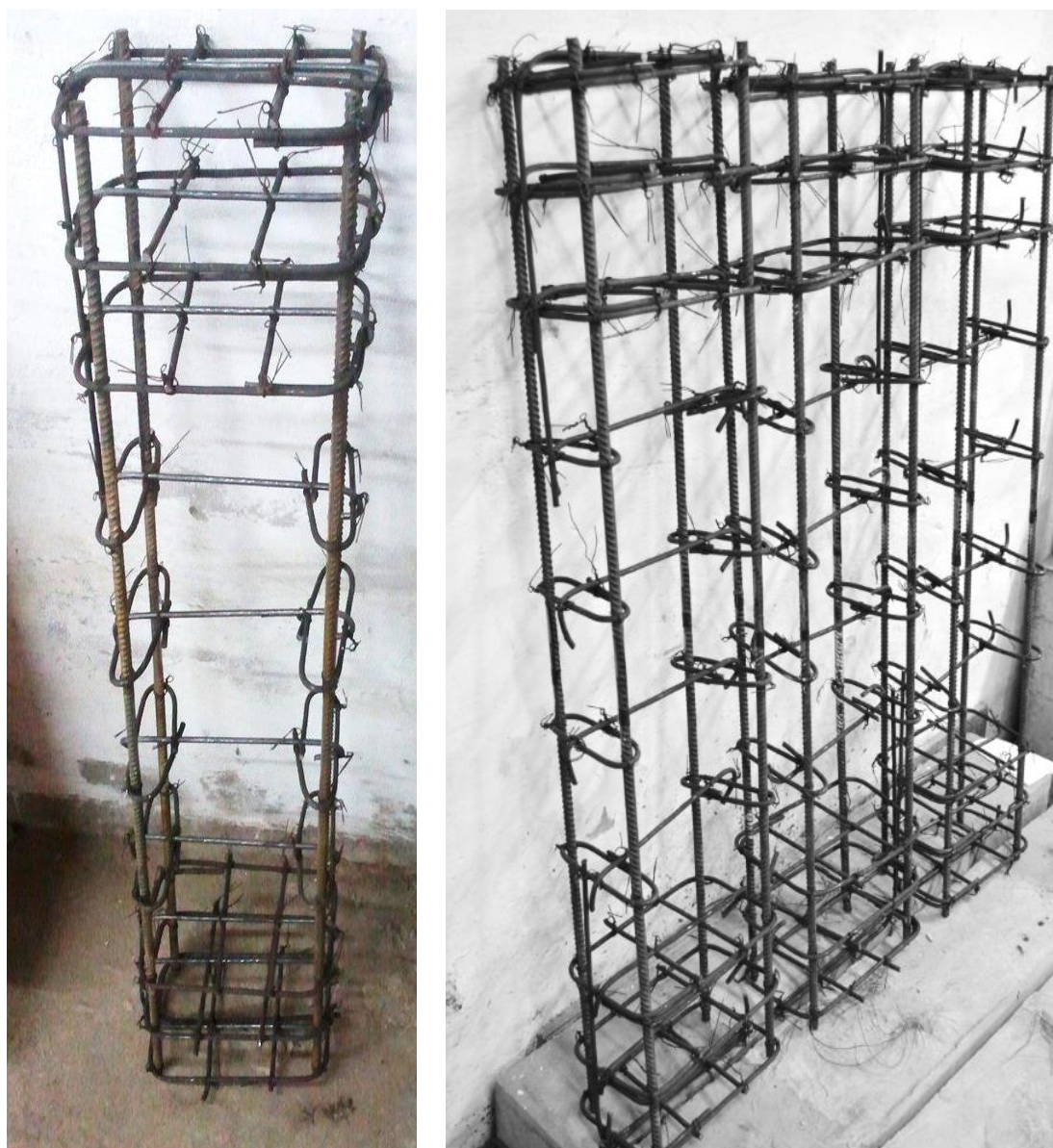
Рис. 2.7. Просторовий арматурний каркас
