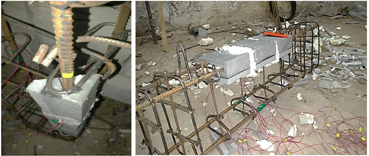
Рис. 2.9. Монтаж моделей пошкоджень на проєктні місця
