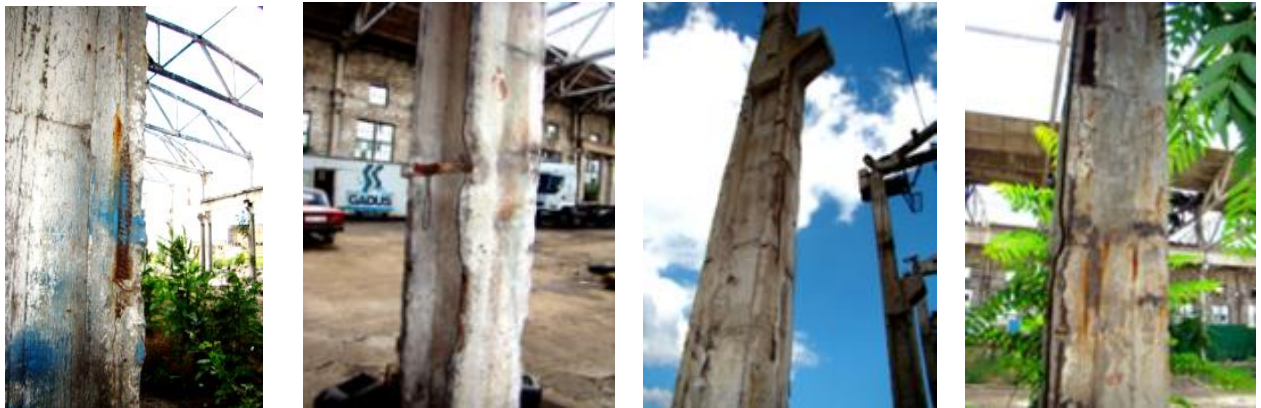
Рис. 2.1. Пошкоджені колони двотаврового профілю
