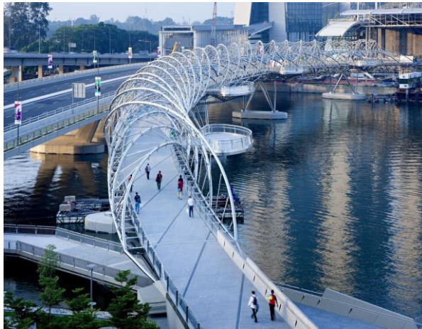
Рис. 6. Міст Хелікс. Загальний зовнішній вигляд
