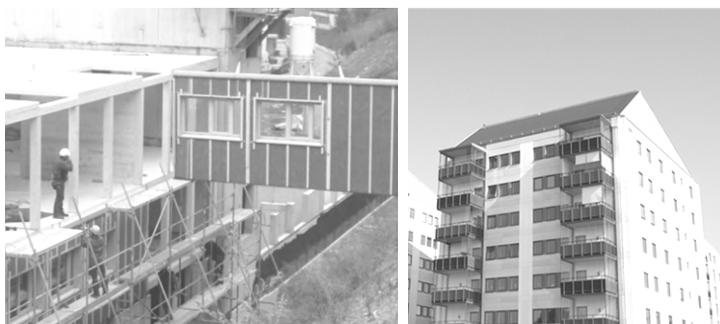
Рис. 3 Многоэтажные дома с деревянным каркасом
