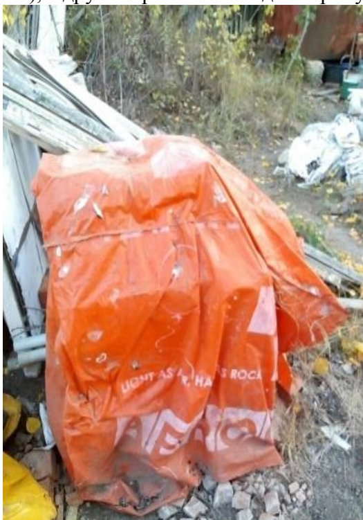
Рис.1. Зберігання першої партії цементу під відкритим небом
