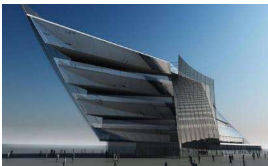
Рис. 6. Бизнес-центр, г. Ереван, проект на строительство утвержден в 2010г.
