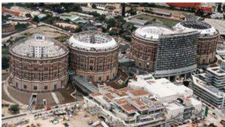
Рис. 1. Фасады газометров в Вене после реконструкции.
