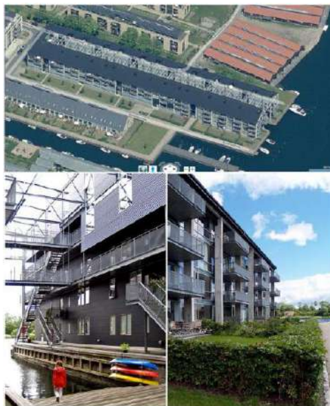
Рис. 3. Реконструкция под жилье протяженных складов в Сан-Франциско.
