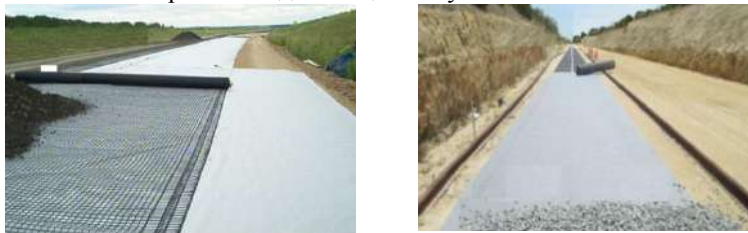
Рис. 2. Використання геосинтетичних решіток на об'єкті.
