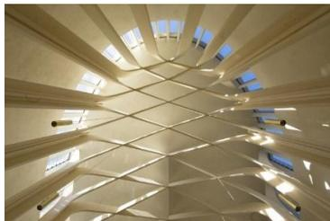
Рис. 4. Сборные секции клееных деревянных конструкций
