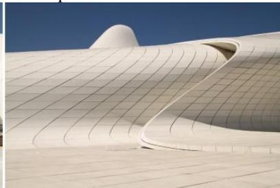
Рис. 5. Панели из стеклопластика и стеклофибробетона
