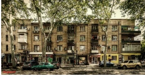
Рис. 3. Жилой дом сотрудников треста «Пищевик» по улице Пушкинской в Одессе. Архитектор Н.М. Каневский, 1930г.
