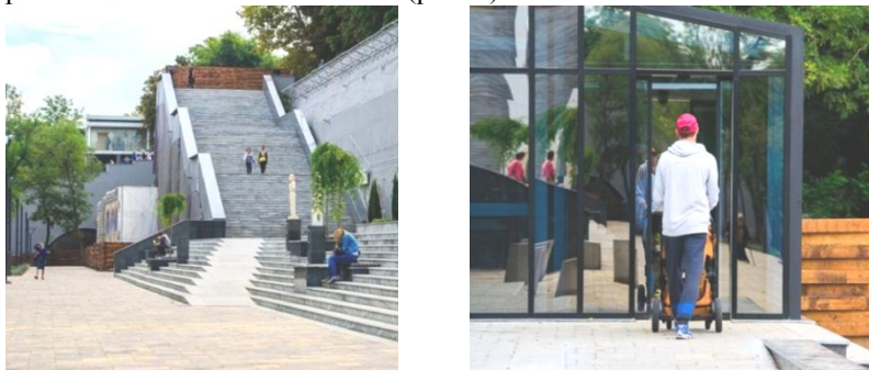
Рис. 6. Устройство пандусов и лифта в Греческом парке
