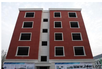
Рис. 1. Один из построенных на 3D-принтере домов компании Shanghai WinSun Decoration Design Engineering Co, июнь 2014 г.
