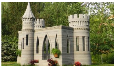
Рис. 2. 3D-печатный замок компании Totalkustom, август 2014 г.
