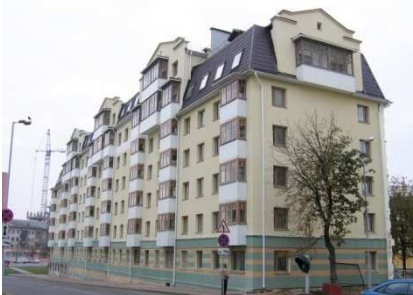
Реконструкція п'ятиповерхового будинку Мінськ, Білорусь з надбудовою мансардного поверху та без виселення
