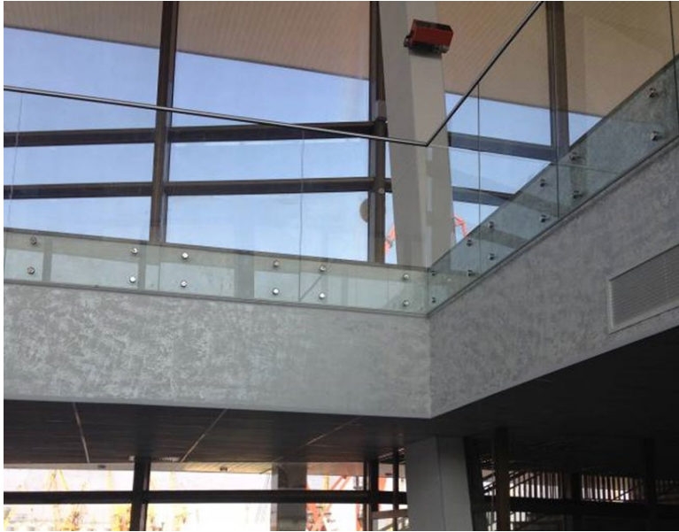
Рис. 2. Ограждение из закаленного стекла на пассажирском терминале Одесского морского порта
