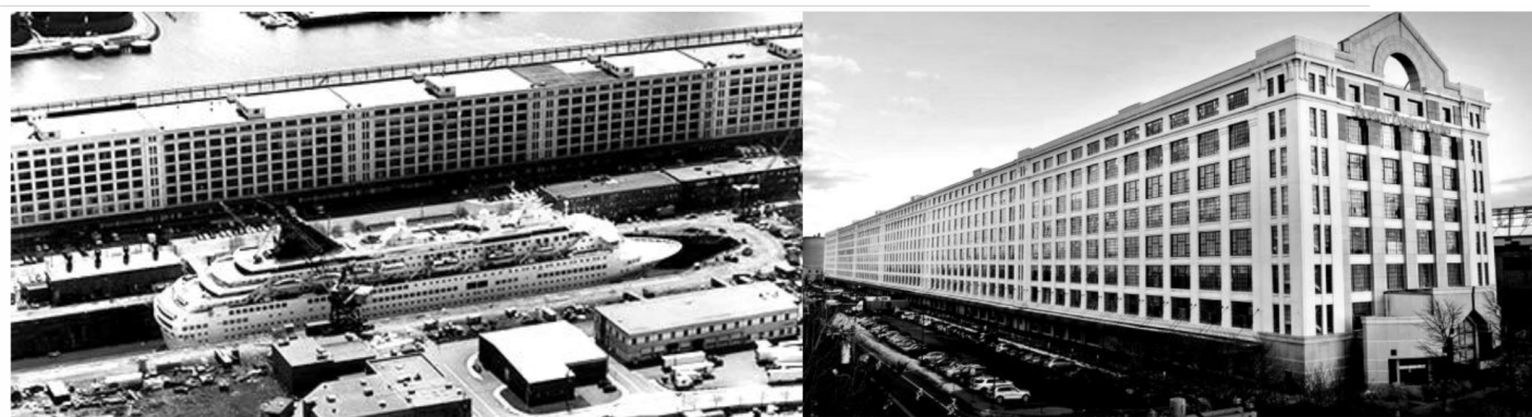
Рис. 2 Многофункциональный инновационный и технологический центр в реконструированном промышленно - складском здании 1918 г. постройки в Бостоне, США
