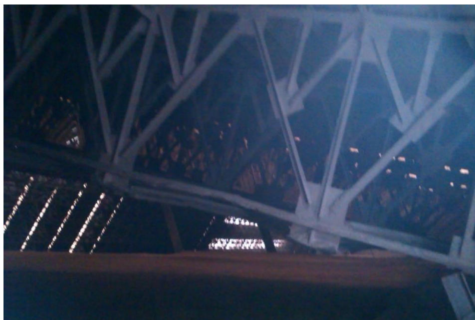
Фото 1. Усиленная стальная стропильная ферма с помощью дополнительной шпренгельной решетки
