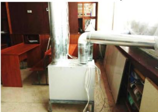
Рис. 6, 7 Модернізована припливно-витяжна система вентиляції з рекуператором і інтелектуальною системою управління
