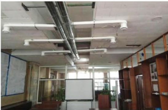
Рис. 6, 7 Модернізована припливно-витяжна система вентиляції з рекуператором і інтелектуальною системою управління
