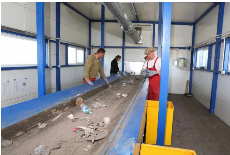
Рис. 4. Помещение сортировочной кабины с механической вентиляцией (сеть воздуховодов)
