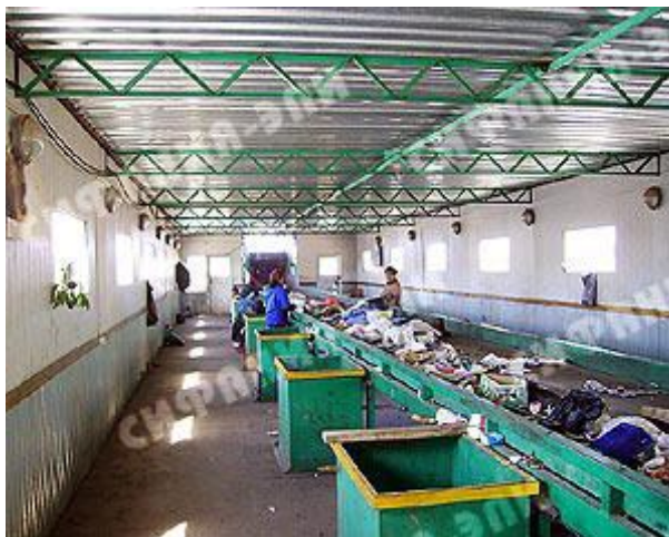
Рис. 2. Помещение сортировочной кабины с естественной вентиляцией
