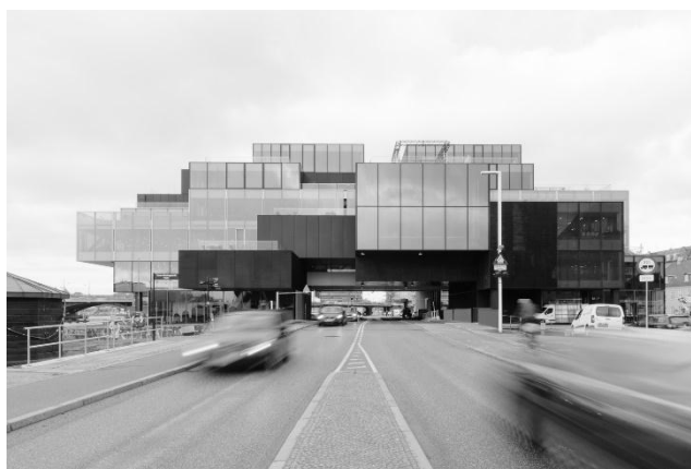
Рис. 3. Здание BLOX, Копенгаген
