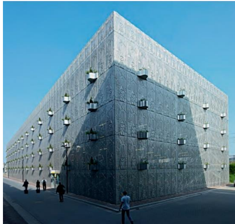
Рис.10 Прозрачный стальной фасад: многоэтажная парковка, Альмере, Нидерланды.
