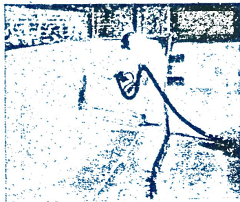
Рис. 2-Напыление полимочевины
