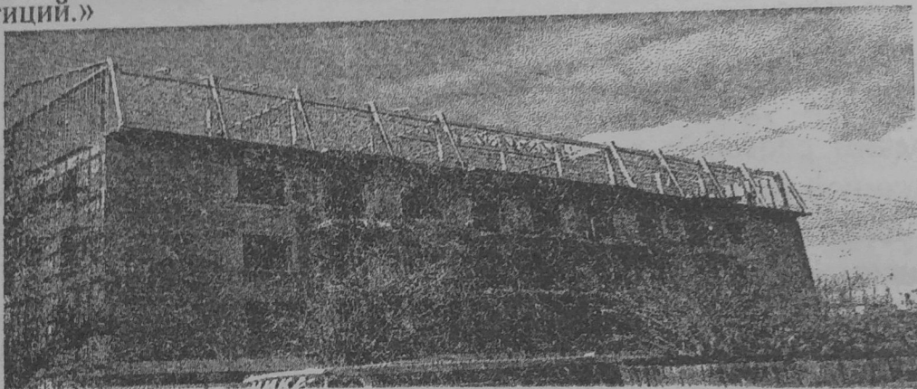
Рис 1. Устройство мансарды с применением ЛСТК на ул. Краснова 34/2
