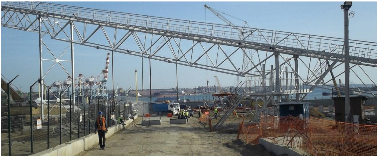
Рис. 4. Пролетное строение ПС-3 конвейерной галереи при загрузке четырьмя блоками
