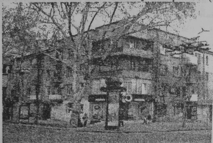
Рис.4. Фото дома работников треста «Пищевик» по ул. Пушкинская, 39 (2014г.)
