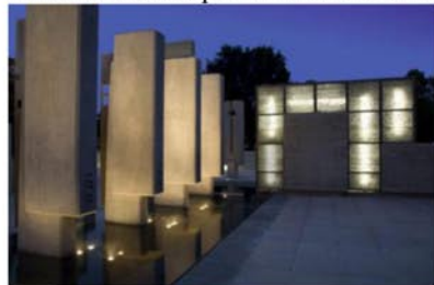
Рис. 1. Декоративная стена из прозрачного бетона
