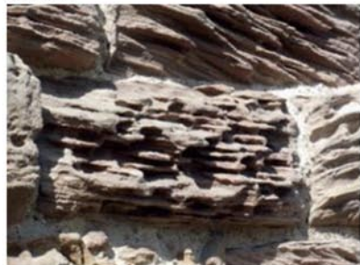
Рис. 1. Гнилой камень, еще не вызывает структурных проблем
