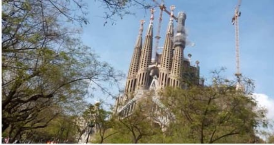
Рис. 4 Споруда в процесі будівництва
