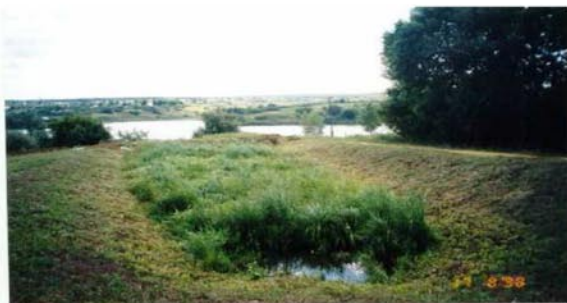
Рис.2. Этапы строительства сооружения фитотехнологии
