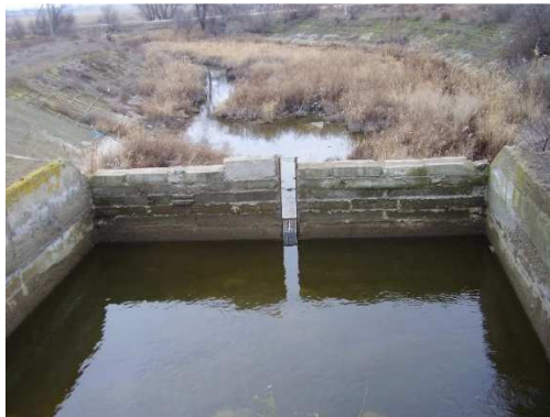
Фото 2. Водобійний колодязь водозливу
