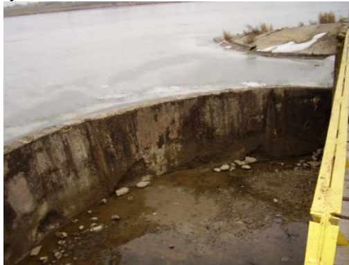
Фото 1. Переливний водозлив греблі
