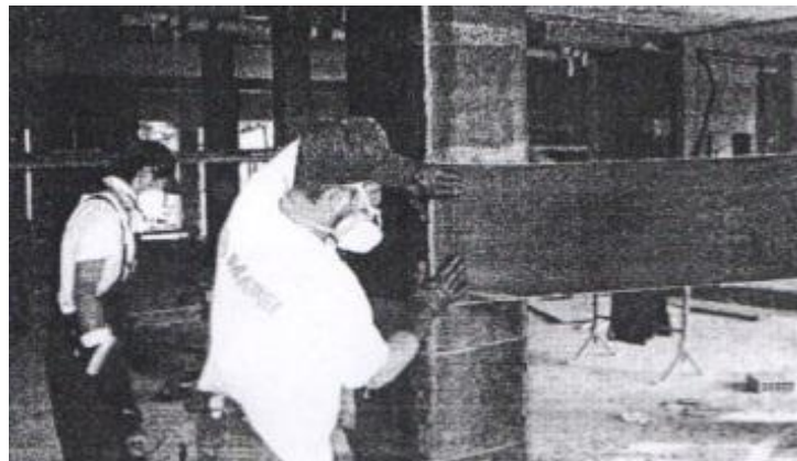
Рис. 5. Усиление прочности колонны на сжатие и жесткости с помощью ткани из углеродных волокон фирмы Mapei
