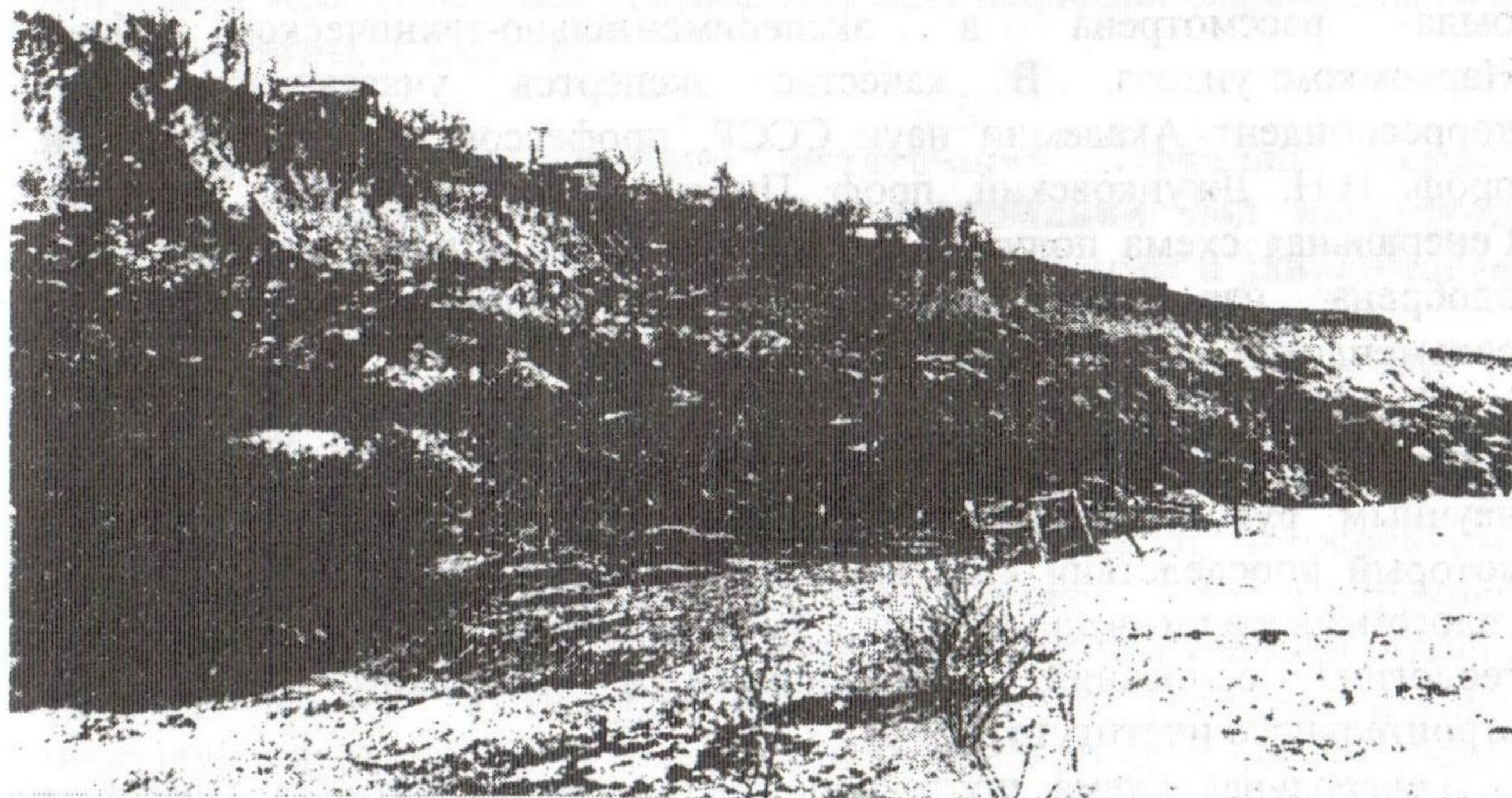
Рис. 2. Оползень в районе Черноморки
