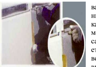
Рис. 4.49. Установка кассеты справа
