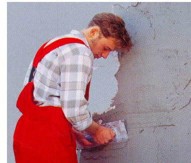
Рис. 2.35. Нанесение штукатурной смеси
