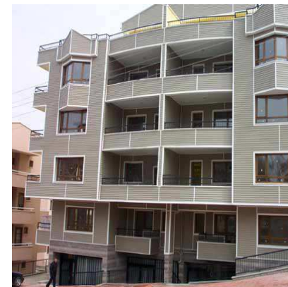
Рис. 5.13. Фасад жилого дома, облицованный виниловым сайдингом
