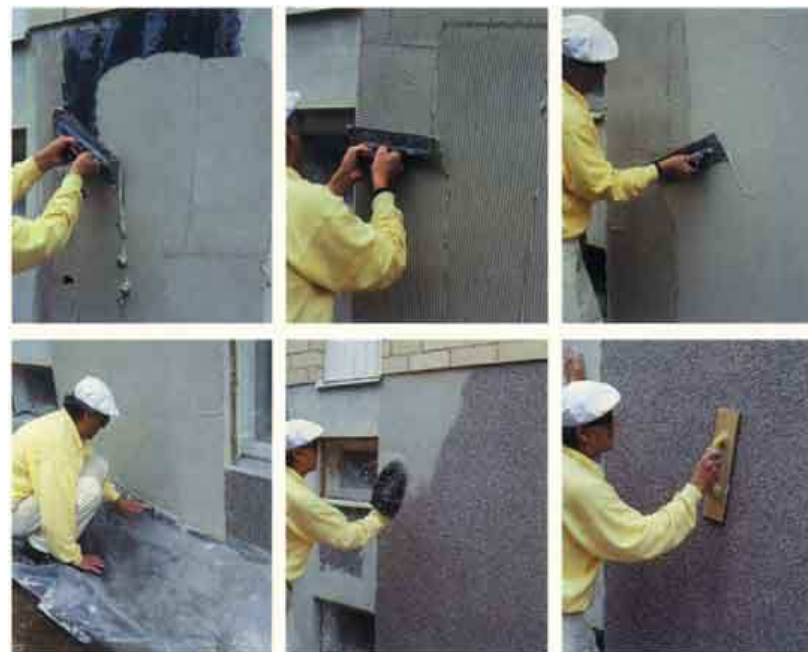
Рис. 2.7. Нанесение облицовочного раствора с минеральной крошкой.
