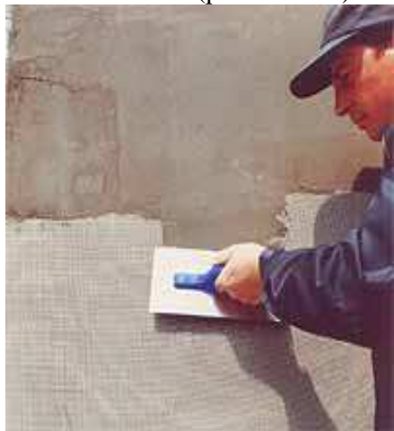
Рис. П.2.30. Затирка армирующей сетки
