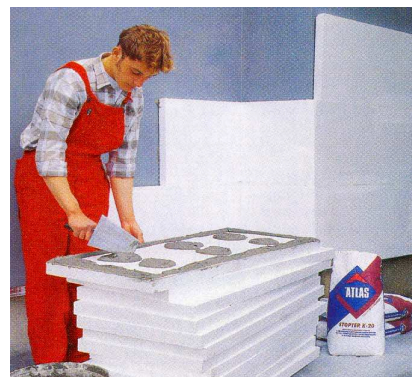
Рис. 2.24. Нанесение клея
