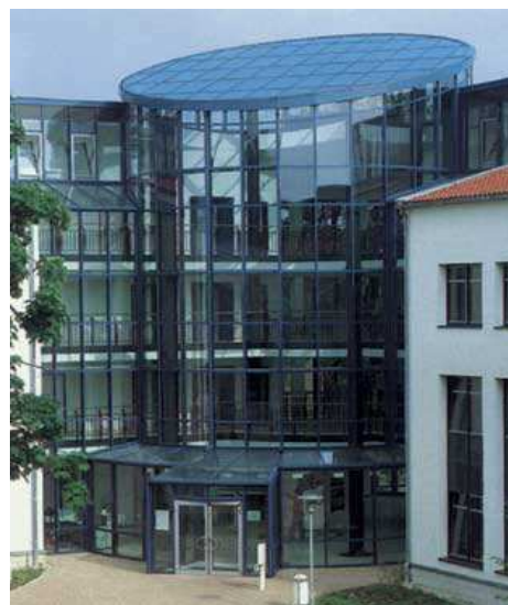
Рис. 6.7. Фасад административного здания (стальные профили фирмы JANSEN)
