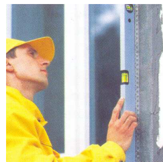
Рис. П.2.24. Усиление внешних углов
