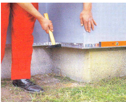
Рис.2.23. Крепление профиля
