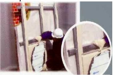
Рис. 4.48. Монтаж кассеты на стартовую планку
