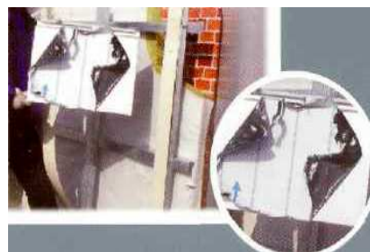
Рис. 4.47. Удаление пленки с поверхности кассеты
