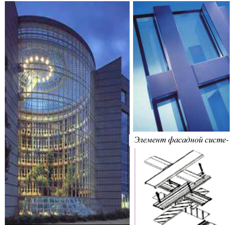
Рис. 6.12. Фасадная система Schuco с видимой шириной стойки-ригеля 60мм
