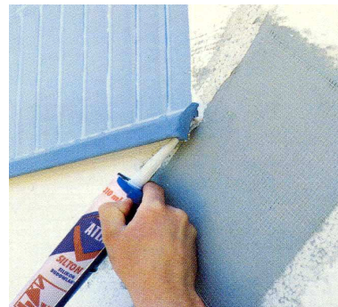
Рис. 2.30. Уплотнение стыков
