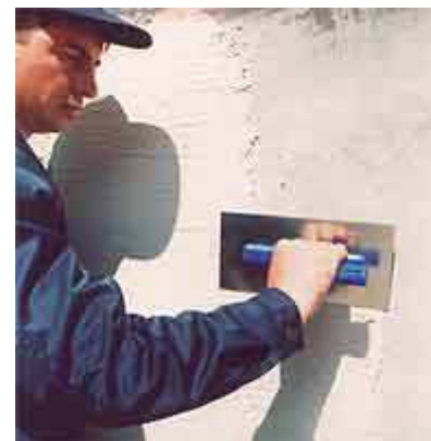
Рис. П.2.32. Нанесение защитного слоя
