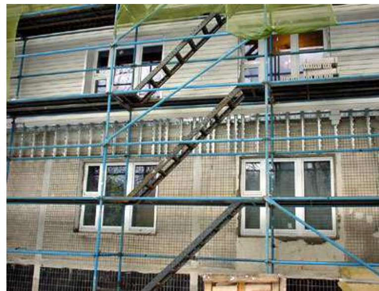
Рис. П.2.1. Установка лесов
