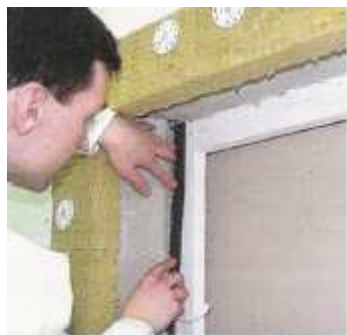
Рис. П.2.18. Наклейка уплотнительной ленты с напуском на коробку
