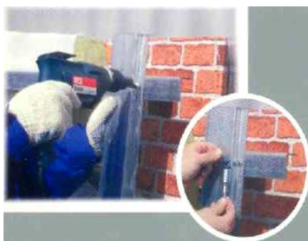
Рис. 4.45. Установка вертикальных шляпных профилей
