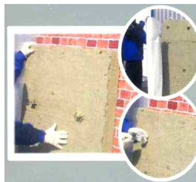
Рис. 4.43 Установка утеплителя
