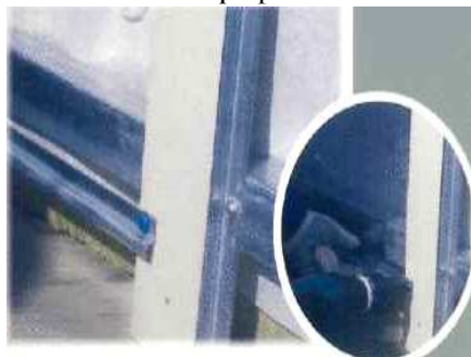
Рис. 4.45. Установка вертикальных шляпных профилей
