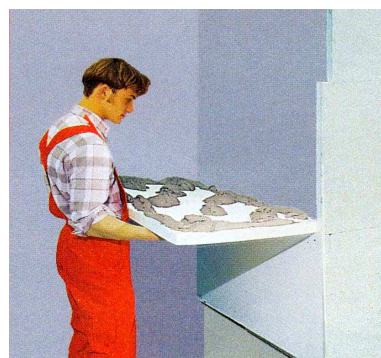
Рис. 2.25. Приклеивание плит пенополистирола
