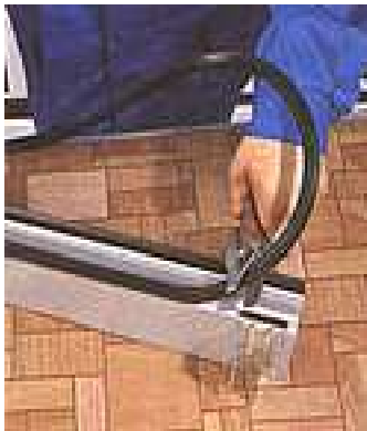
Рис. 6.19. Укладка в пазы уплотнительной резины
