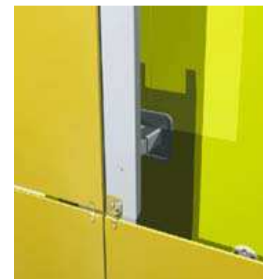
Рис. 3.11. Крепление облицовки к направляющим с помощью кляммеров
