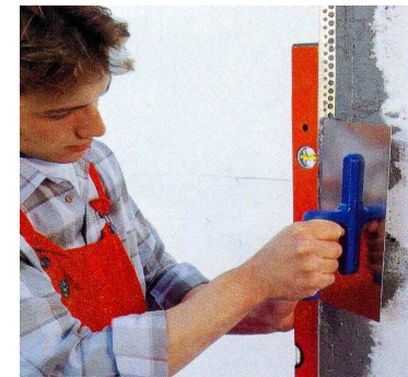
Рис. 2.31. Укрепление углов защитными профилями
