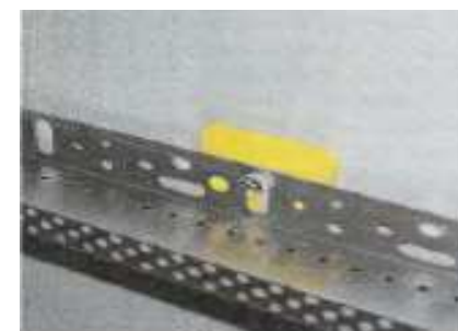
Рис. П.2.6. Установка подкладочной шайбы
