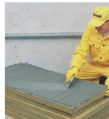
Рис. П.2.9. Нанесение клеевого состава сплошным способом
