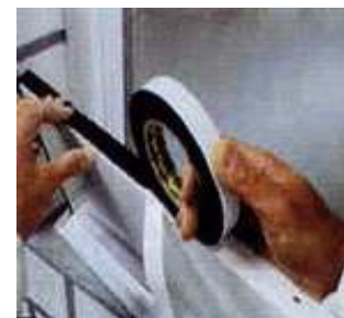
Рис. П.2.15. Наклейка противозвучной ленты
