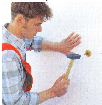
Рис. 2.29. Закрепление дюбеля
