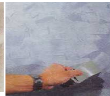
Рис. 2.4. Разгоняя краску кусочком тонкого листового пластика с закругленными краями можно получить фактуру «под черепаховый панцирь»
