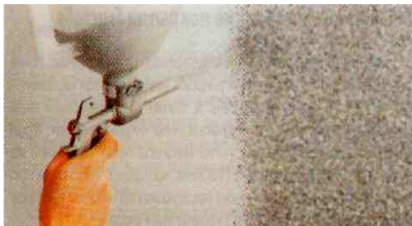
Рис. 2.2. Нанесение декоративного покрытия пистолетом
