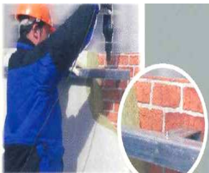
Рис. 4.44. Установка горизонтальных направляющих профилей
