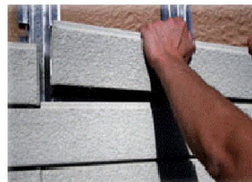
Рис. 4.10. Монтаж панелей облицовки
