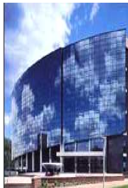
Рис. 6.13. Фасадная система Schuco со структурным остеклением
