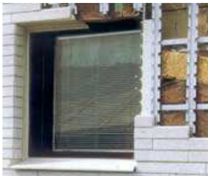
Рис. 4.11. Отделка оконного проема
