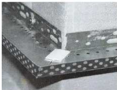
Рис. 4.9. Формирование угла цокольным профилем
