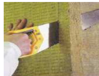
Рис. П.2.12. Обрезка теплоизоляционного материала
