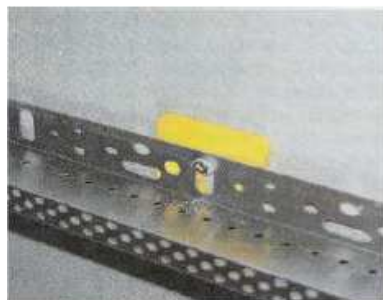
Рис. 4.8. Установка соединительных элементов и подкладочных шайб
