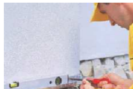
Рис. П.2.5. Установка цокольного профиля
