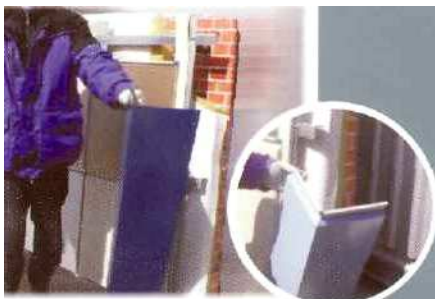
Рис. 4.51. Установка доборных элементов
