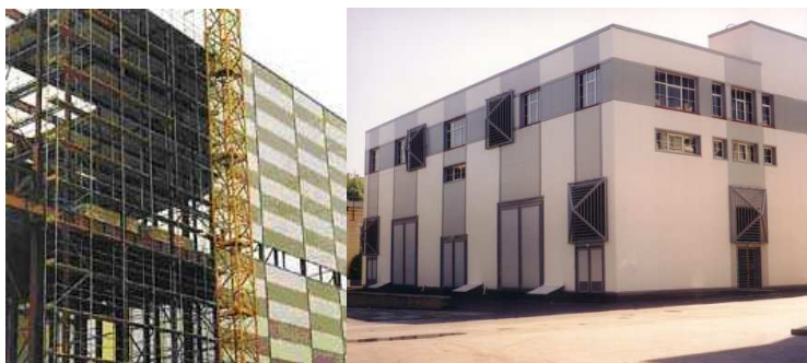
Рис. 4.38. Рабочий момент монтажа и фасад, обустроенный Ruukki Panel
