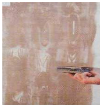
Рис. 2.5. Для отделки «под дерево» необходим специальный раскатчик из резины. В зависимости от ритма рисунка увеличивается или уменьшается амплитуда движений
