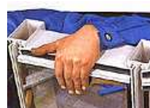
Рис. 6.22. Крепление ригеля к стоечному профилю
