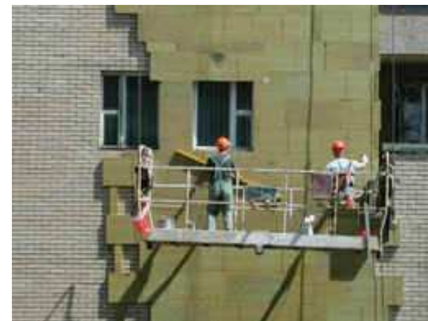
Рис. 2.19. Монтаж теплоизоляции на фасад с люлек.
