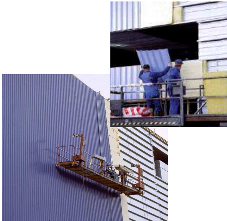
Рис. 4.40. Рабочие моменты монтажа Ruukki Casetti Характеристики фасадных облицовок Ruukki
