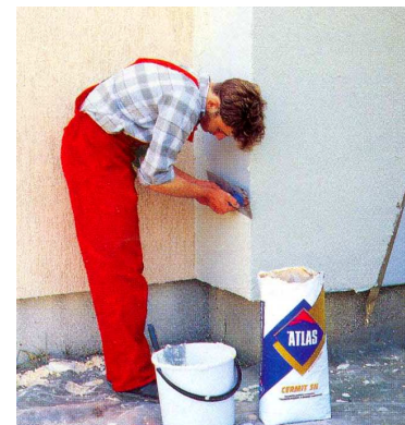
Рис. 2.36. Удаление излишков смеси
