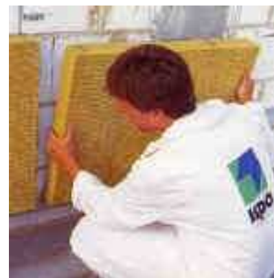
Рис. П.2.10. Установка первого ряда теплоизоляционных плит
