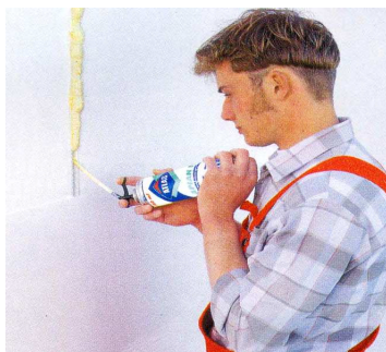
Рис. 2.26. Заделка стыков монтажной пеной
