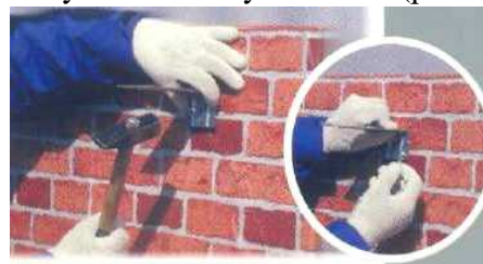
Рис. 4.42. Установка кронштейна
