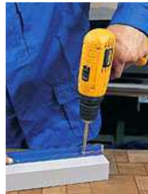
Рис. 6.20. Крепление алюминиевых уголков
