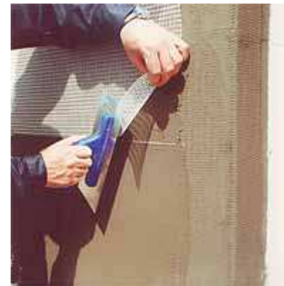
Рис. П.2.29. Армирование щелочестойкой сеткой
