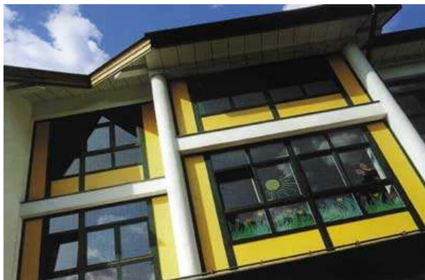
Рис. 5.12. Облицовка фасада ламинированными панелями
