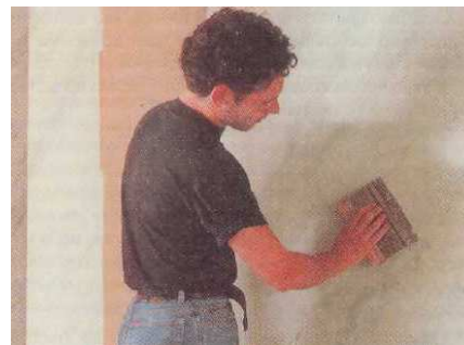
Рис. 2.3. Осторожными движениями шпателя в одном направлении можно разглаживать смешанные составы
