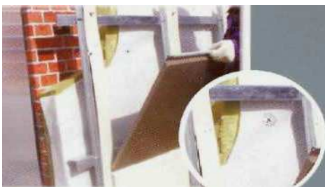
Рис. 4.50. Установка кассеты сверху
