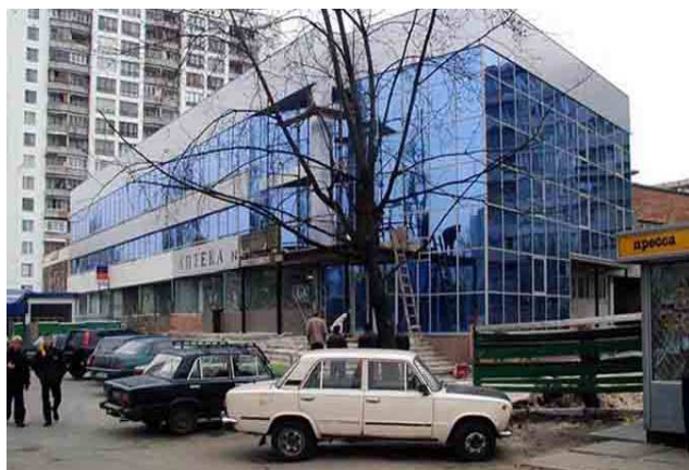
Рис. 6.6. Фасад торгового дома в г. Киеве (алюминиевый профиль «Талисман»)
