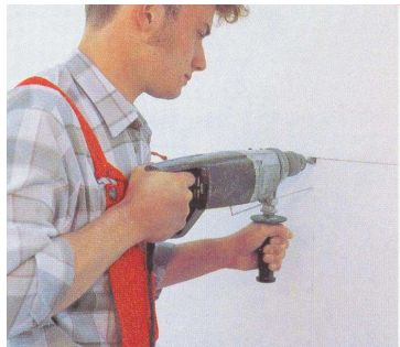
Рис. 2.28. Устройство отверстий под дюбели.
