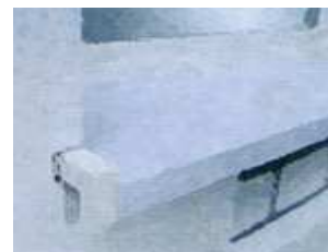
Рис. П.2.17. Установка угловой плиты
