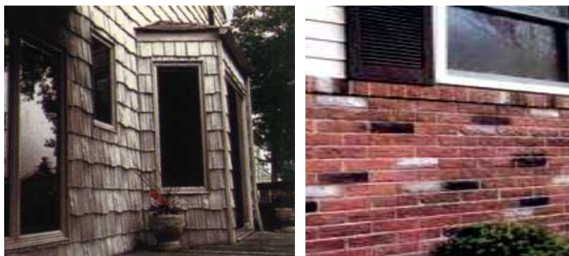
Рис. 5.19. Облицовка фасадов полипропиленовыми панелями
