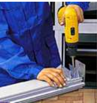
Рис. 6.18. Крепление Т-форбидера, профиля и "башмака" шурупами-саморезами
