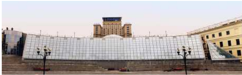
Рис. 6.3. Наклонный витраж в г. Киеве на Майдане Незалежности
