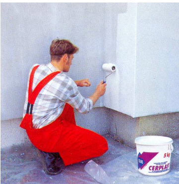
Рис.2.34. Нанесение грунтовочного слоя
