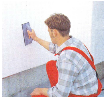
Рис.2.27. Шлифовка поверхностей
