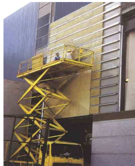
Рис. 4.6. Монтаж теплоизоляции с использованием самоходных подмостей
