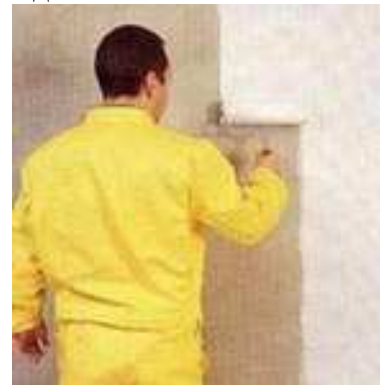
Рис. П.2.31. Нанесение грунтовки
