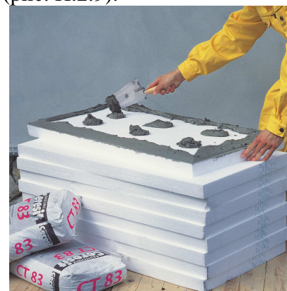
Рис. П.2.8. Нанесение клеевого состава маячковым способом
