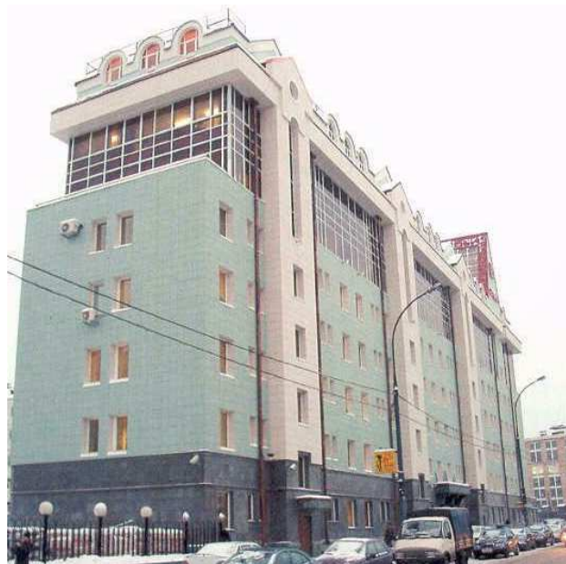
Рис. 5.10. Фасад, облицованный керамическим гранитом
