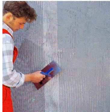
Рис. 2.33. Наложение армированной сетки.
