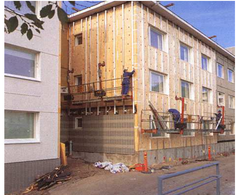
Рис. 4.5. Рабочий момент монтажа фасадной системы с использованием люлек
