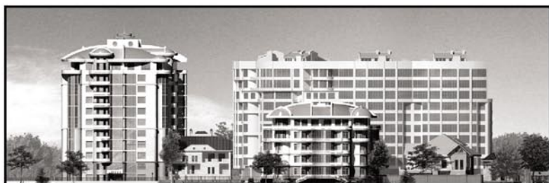
Рис. 5. Строящиеся 5-ти и 10-ти этажные жилые дома (Мукачевский пер. в г. Одесса) Арх. Базан Н. К. Вид со стороны побережья.
