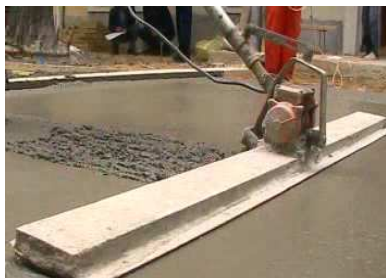
Рис. Ж.3. Выравнивание бетонной смеси
