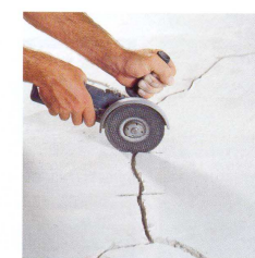
Рис.2.32. Прорезка поперечных швов
