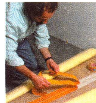
Рис.6.12. Укладка клеящей ленты
