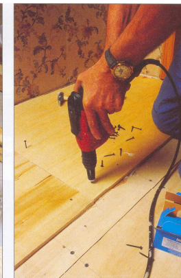
Рис.5.12. Установка фанеры по лагам (крепление второго слоя фанеры на клей и шурупы)
