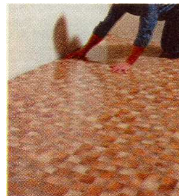
Рис.6.11. Укладка и разглаживание линолеума
