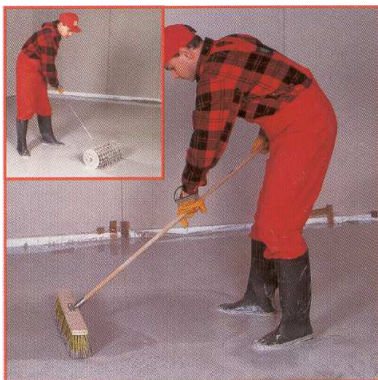
Рис.2.81. После окончания выливания масса предварительно выравнивается и распределяется с помощью широкой щетки с твердыми длинными волосами (встряхивающими движениями), а также валиком или алюминиевой рейкой.
