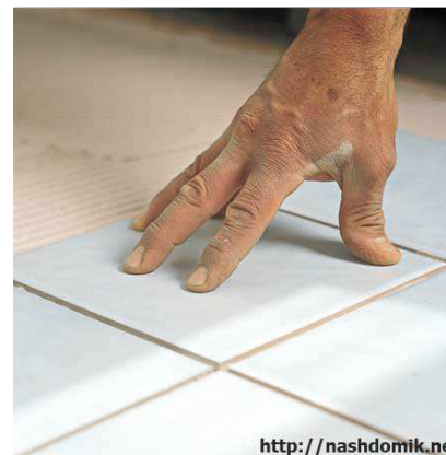
Рис.5.57. Укладка плитки на основание
