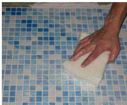
Рис.5.71. Удаление с мозаичных полов остатков клея или затирки
