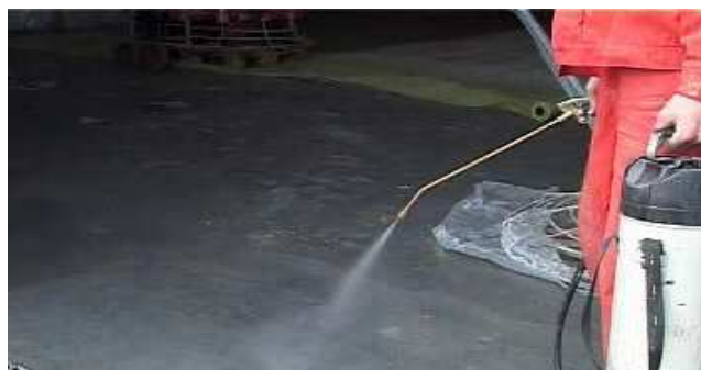
Рис.4.20. Напыление препарата BAUSEAL
