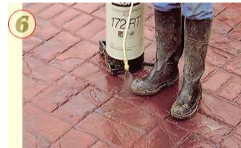
Рис.4.41. Пропитка сухой поверхности акриловым препаратом BAUSEAL придаёт ей интенсивный цвет и предотвращает проникновение воды, масел, смазок и т.п. в тело бетона.
