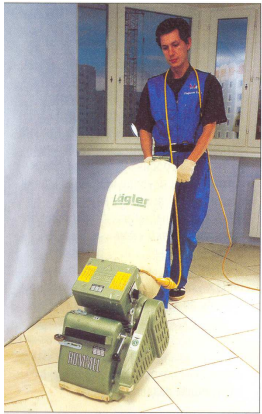
Рис.5.13. Шлифовка фанеры по уровню
