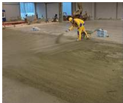
Рис.Ж.4. Рассыпка отвердителя
