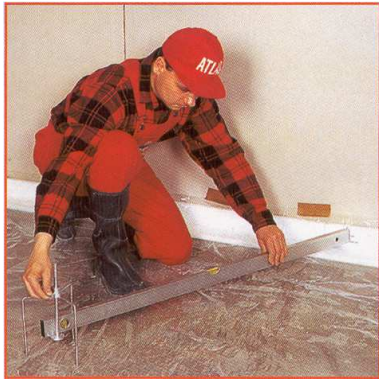
Рис.2.79. Предварительно выставленный уровень (на стене) переносится с помощью реперов на всю поверхность, образуя снелированную для этой цели сетку толщиной слоя выливания.
