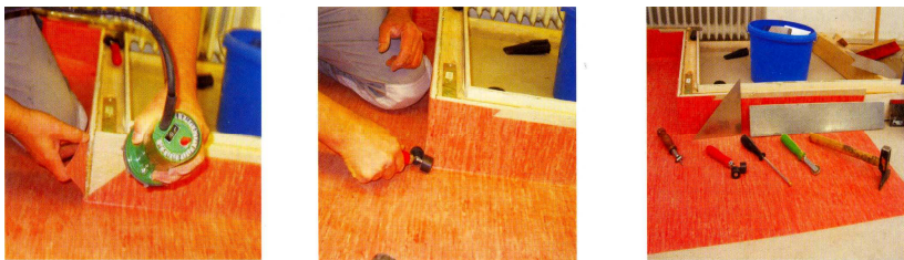
Рис.2.65. Разогрев ПВХ и клея феном с последующей укладкой ПВХ и притиркой молотком
