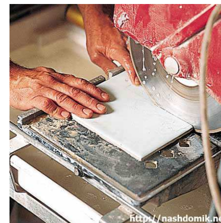
Рис. 5.59. Резка плитки «болгаркой»
