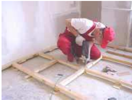
Рис. Е.8. После крепления лаг, делается обрешетка, т.е. между лагами ложатся ригели на бобышки и крепятся к ним саморезами.
