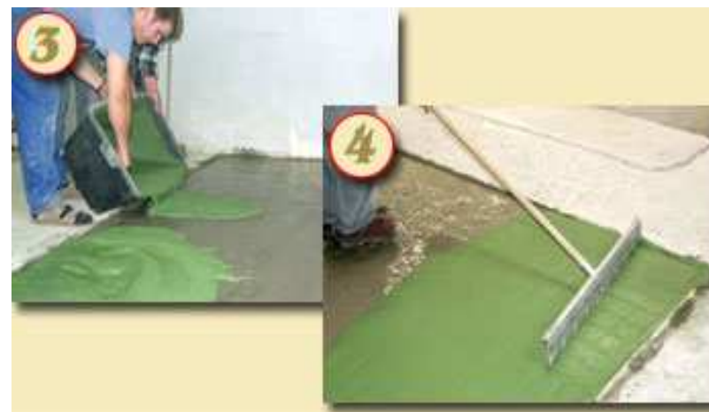
Рис.4.25. Укладка слоя BAUFLOOR при помощи ручной стальной рейки.
