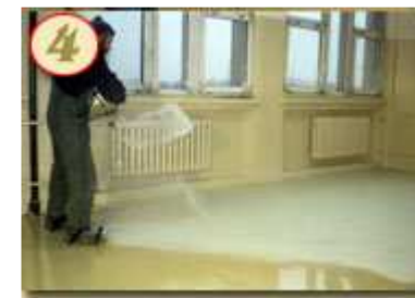
Рис.4.31. Посыпка досуха кварцевым песком на подготовленный слой эпоксидной массы
