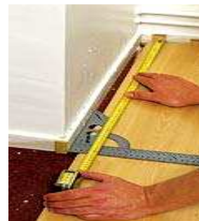
Рис.5.39. Если необходимо отрезать часть планки неправильной формы для укладки у стены или у разделительной перегородки, измерьте длину и ширину нужного отрезка ламината с учетом зазора между стенкой и планкой.
