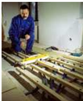
Рис.2.2. Начальный этап работ
