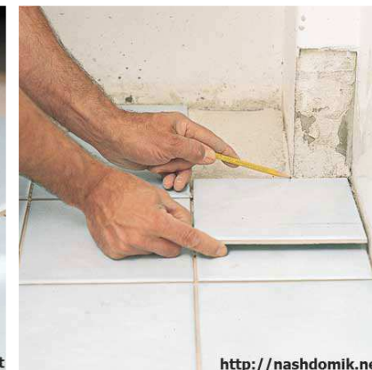
Рис. 5.58. Разметка плитки карандашом в сложных местах
