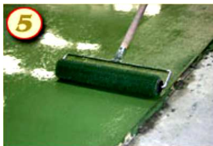
Рис.4.26. Удаление воздуха из слоя BAUFLOOR при помощи валика с иглами
