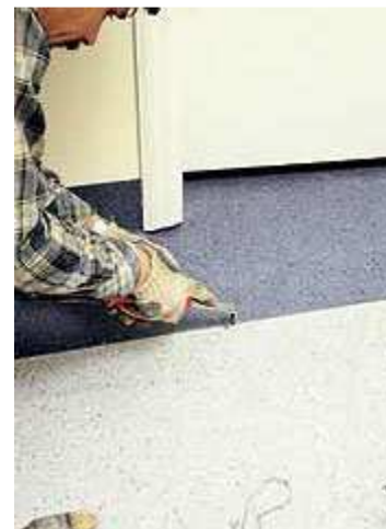
Рис.6.16. Выполнение паза между полотнищами линолеума
