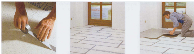
Рис.2.50. Укладка покрытий на плиты UZIN – Multimoll Protect
