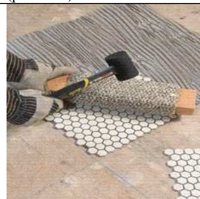
Рис.5.73. Укладка первого листа при помощи резинового молотка
