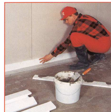
Рис.4.12. После отчистки основания укладываем изолирующие слои у стены, (при необходимости и по середине) из изолирующей тесьмы или полос пенополистирола
