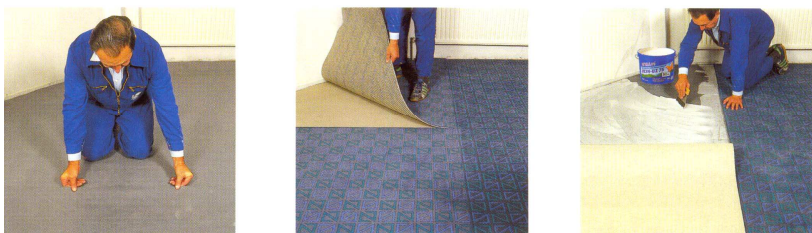
Рис.2.63. Приклеивание покрытия на подложку UZIN-RR 188
