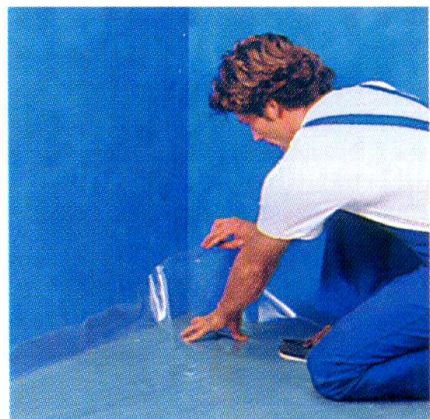
Рис.Г.3. Укладка гидроизолирующей пленки
