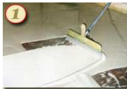
Рис.4.28. Нанесение и укладка слоя выравнивающей шпаклевочной массы на загрунтованное бетонное основание
