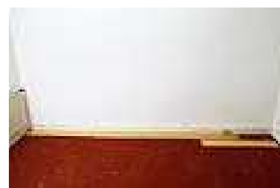
Рис.5.34. Вдоль стены, от которой начинаете работу, уложите первый ряд планок в направлении падения дневного света, вставив клинья (2-3 шт.) между ламинатом и стеной для обеспечения зазора, так как ламинат после укладки может раздвинуться по периметру всей комнаты до 8 мм. В дальнейшем этот зазор закрывается плинтусом..
