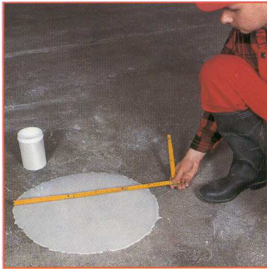
Рис.4.15. После проверки растекаемости массы, подаваемой агрегатом, приступают к выливке основания для пола
