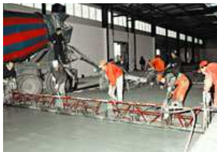
Рис.А.4. Виброрейка с пневматическим приводом
