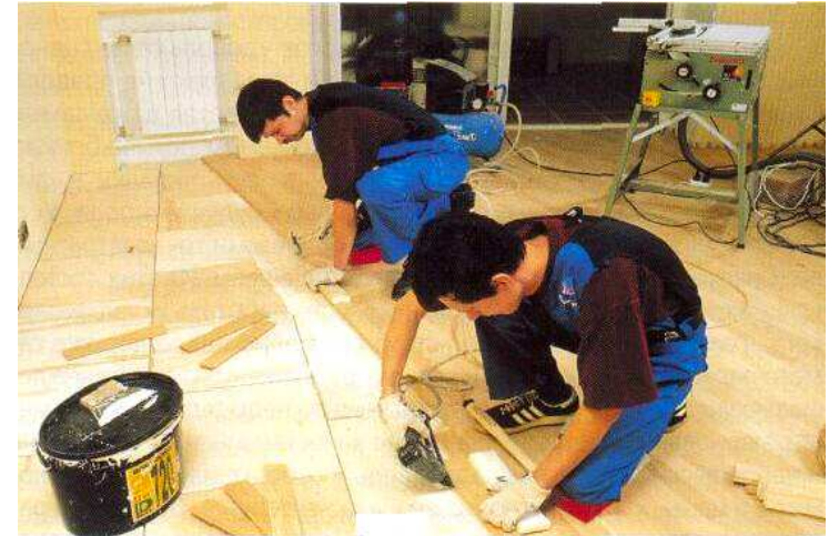
Рис.5.19. Процесс укладки паркета на объекте
