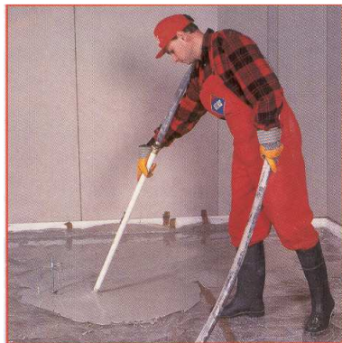
Рис.2.80. Масса выливается смесительно-нагнетательными агрегатами, непрерывно и равномерно распределяя до высоты, установленной реперами.
