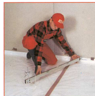
Рис.4.14. Устанавливаются реперы, определяется горизонтальность плоскости по реперам. Устанавливают толщину выливаемого основания с помощью правила с уровнем или длинной контрольной линейки-уровня.
