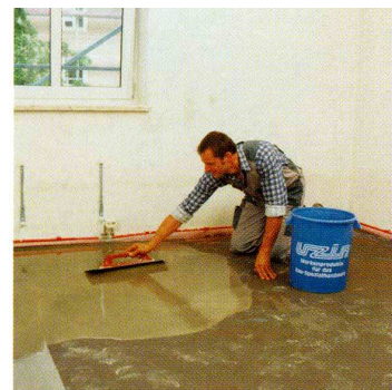
Рис.2.60. Распределение нивелирмассы
