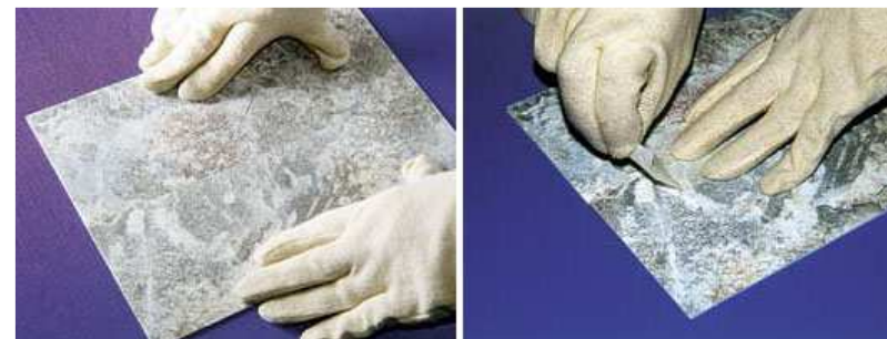
Рис.6.19.Стыковка полотенц линолеума и заклеивание стыка скотчем
