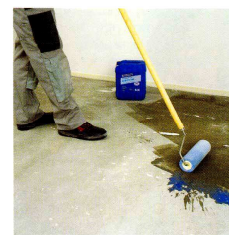
Рис.2.46. Нанесение грунтовки
