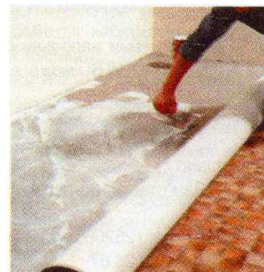
Рис.6.10. Нанесение слоя клеящего состава
