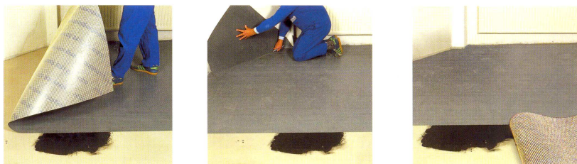
Рис.2.62. Укладка стабилизирующей подложки UZIN-RR 185
