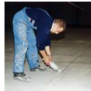
Рис.4.22. Заполнение швов массой BAUFLEX
