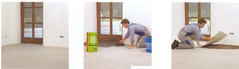
Рис.2.49. Укладка плит UZIN – Multimoll Protect
