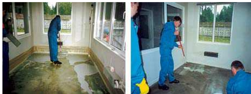
Рис.4.8. Распределение и уплотнение полиуретановой смеси при помощи правила и игольчатого валика
