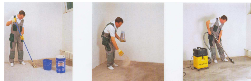
Рис.2.52. Нанесение грунтовки
