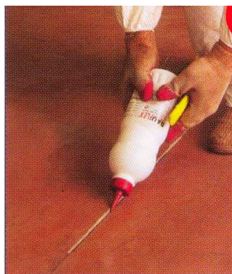
Рис.Ж.9. Заполнение швов массой
