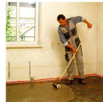
Рис.2.61. Уплотнение смеси игольчатым валиком
