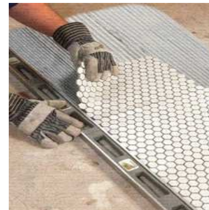
Рис. 5.77. Выравнивание краев с использованием металлического уровня-линейки.
