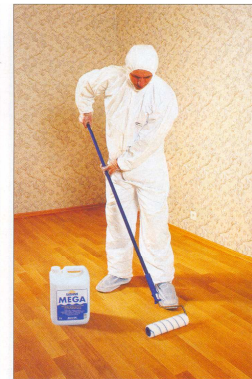
Рис. 5.25. Нанесение грунтовочного слоя лака. Нанесение 2-3 слоев основного лака. Промежуточная су-пертонкая шлифовка лакового покрытия. Нанесение заключительного слоя лакового покрытия
