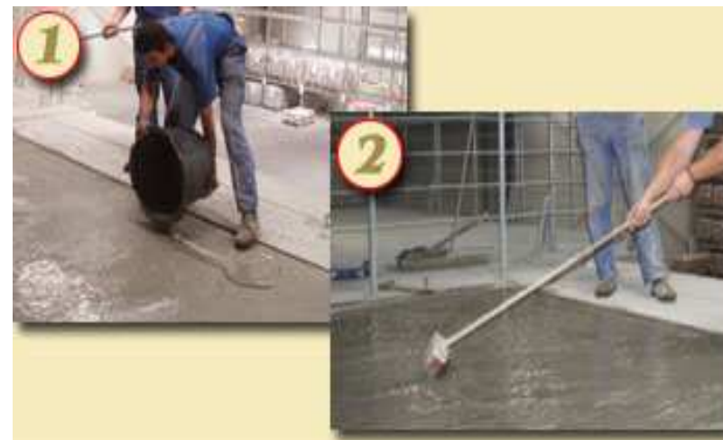
Рис.4.24. Нанесение препарата BAUBOND.
