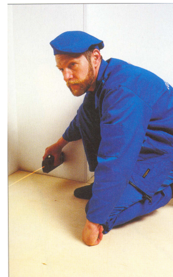
Рис.5.8.Точное определение всех необходимых размеров помещения электронным лазерным измерителем
