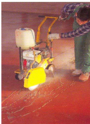
Рис. Ж.8. Нарезка усадочных и рабочих швов
