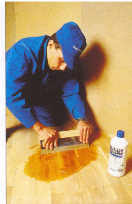
Рис.5.23. Шпаклевка паркета составами на основе древесной пыли
