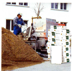
Рис.2.37. Приготовление смеси
