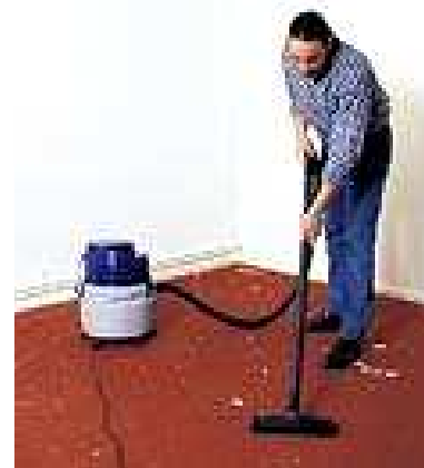
Рис.5.33. Превосходной подложкой может служить ковровин с коротким ворсом. Предварительно его следует тщательно очистить от твердого мусора или частиц, способных создать неровности на ламинатном полу.
