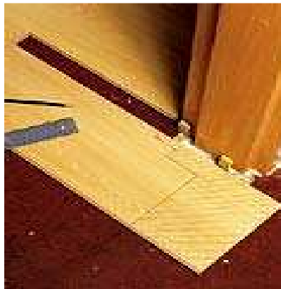
Рис.5.43.Если выбран первый вариант, то нужно нанести контур отреза с учетом зазоров между планкой и косяком. Сделать это можно с помощью транспортира или картонного шаблона.
