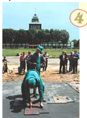
Рис.4.37. Нанесение в соответствующей пропорции цветного отвердителя PRESSBETON - MULTITOP на поверхность свежего бетона
