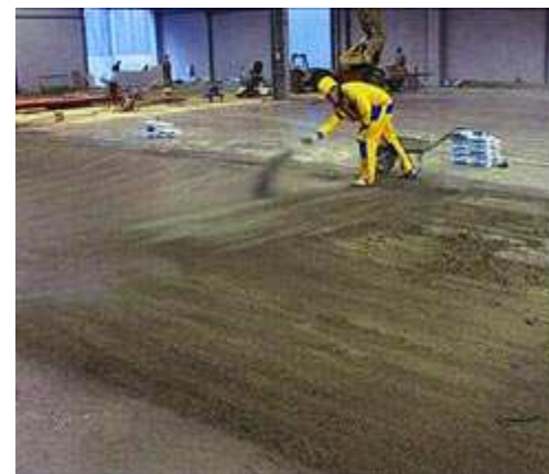
Рис.4.18. Рассыпка отвердителя
