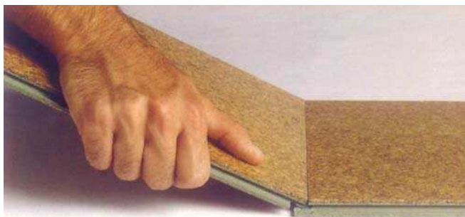
Рис.5.53. Замковое крепление напольных планок из пробки
