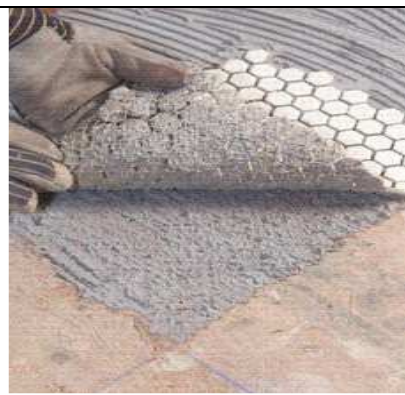
Рис. 5.74. Проверка соприкосновения всех мозаик с раствором
