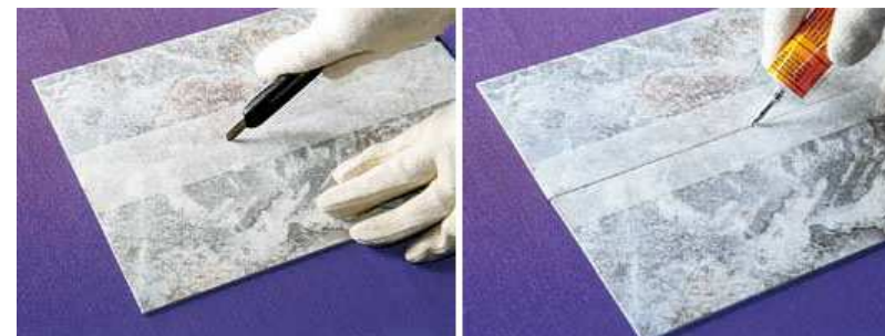
Рис.6.20. Разрезание скотча над стыком и нанесение в него клея
