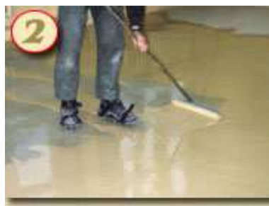
Рис.4.29. Нанесение и укладка слоя эпоксидной массы для посыпки кварцевым песком
