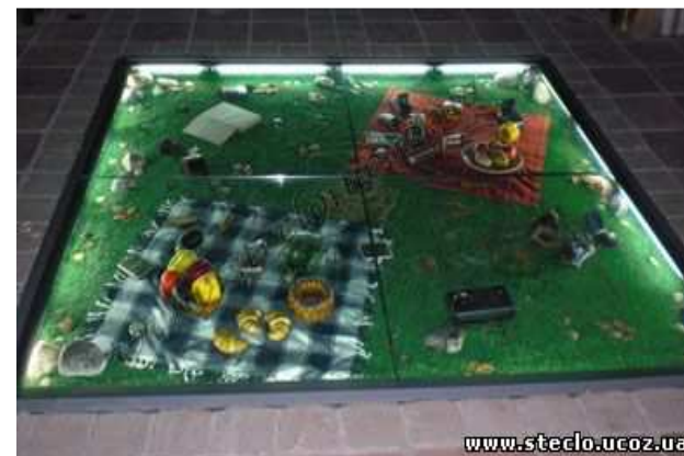
Рис. 5.79. Стеклянное поле, выполняющее функции несущего пола
