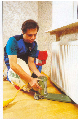
Рис.5.22. Грубая и средняя шлифовка машиной для углов и лестниц
