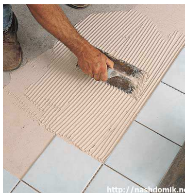
Рис.5.56. Нанесение клея на основание с помощью зубчатого шпателя
