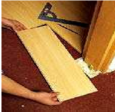
Рис.5.42.Чтобы уложить ламинат около дверной коробки, нужно точно выпилить соответствующий контур планки, но легче вырезать нижнюю часть косяков по высоте ламината.
