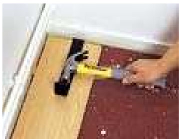
Рис.5.36. Прижать планки, расположенные близко к стене, позволяет специальное приспособление. Нижняя поверхность этого инструмента снабжена войлочными прокладками, чтобы не поцарапать покрытие.
