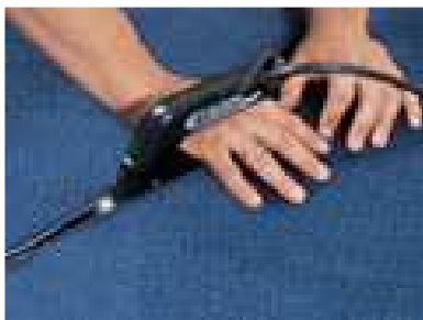
Рис.6.7. Затем с помощью специального утюга края обоих кусков приклеивают к термоленте, плотно подгоняя их друг к другу
