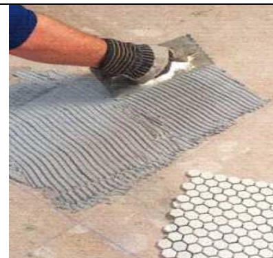
Рис.5.75. Нанесение мозаичного клея зубчатым шпателем
