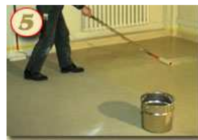
Рис.4.32. Доработка верхнего слоя до насыщения
