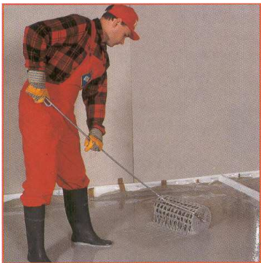
Рис.4.16. Выравнивание и распределение массы после выливки является последней операцией.
