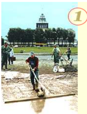
Рис.4.36. Уплотнение вибрационной рейкой композиционного бетона, уложенного на предварительно подготовленное основание
