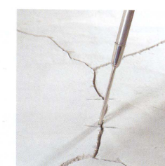
Рис.2.33. Очистка трещин
