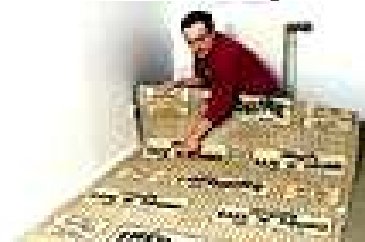
Рис.5.32. Укладка ламината требует наличия амортизирующей подложки, смягчающей звуки и удары. Она должна быть настелена перпендикулярно направлению планок ламината
