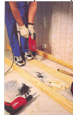
Рис.5.10. Устройство основания под паркет в соответствии с принятой схемой. Установка и крепление лаг
