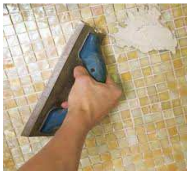
Рис.5.70. Затирка швов
