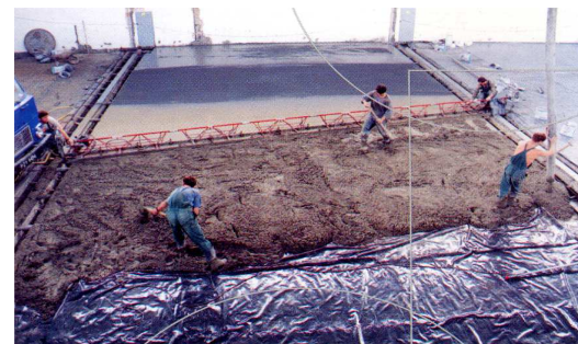
Рис.Ж.2. Укладка бетонной смеси
