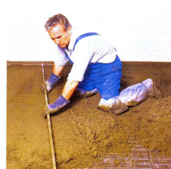
Рис.2.39. Разглаживание раствора
