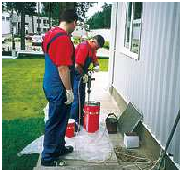
Рис.4.7. Приготовление полиуретановой смеси специальной насадкой
