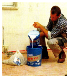
Рис.2.58. Приготовление грунтовки
