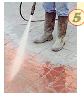
Рис.4.40. Смывание разделителя струей воды с поверхности застывшего бетона
