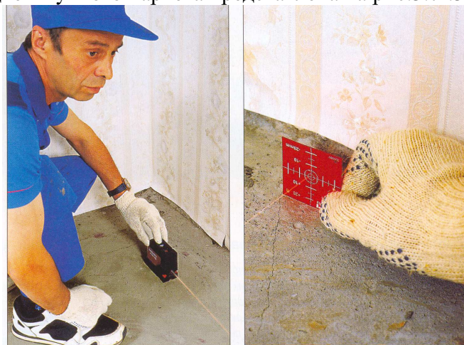
Рис.5.7.Измерение плоскостности и уклона исходного основания лазерным нивелиром
