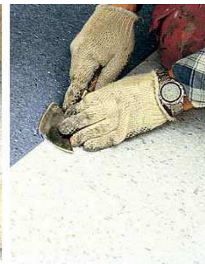
Рис.6.18. Срезание излишков шнура и шлифовка шва
