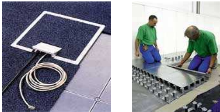
Рис.9.9. Система фальшпола с интегрированными кабельными каналами (INTERFACE)
