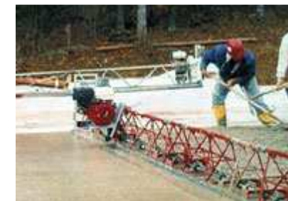
Рис.А.5. Виброрейка с приводом от двигателя внутреннего сгорания
