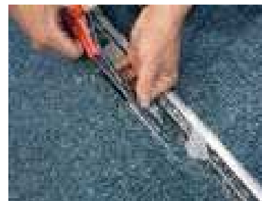
Рис.6.3. Ковровое покрытие можно разрезать и подрезать только специальными ножницами или ножом
