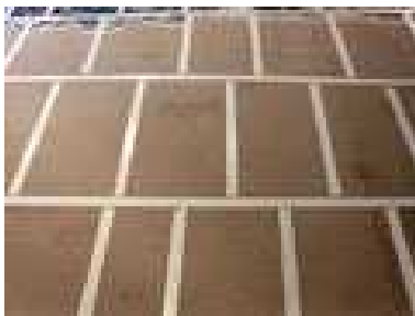
Рис.6.2. В данном примере скотч уложен "сеткой". Подобный способ применяют, как правило, в помещениях большой площади
