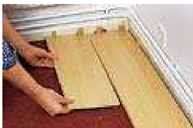
Рис.5.37. Каждый последующий ряд начинайте выкладывать с обрезка планки, оставшегося от предыдущего ряда. Таким образом, будут смещены места стыков, что невозможно при планках одинаковой длины.
