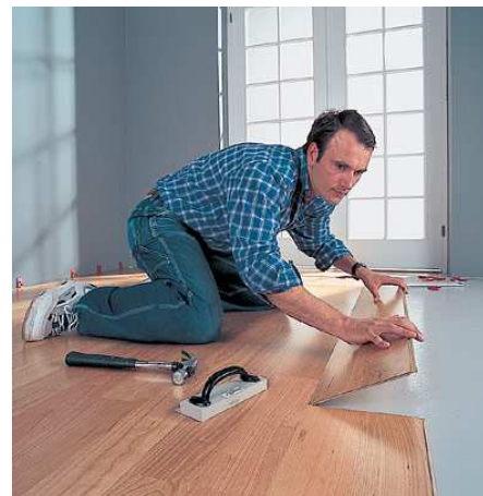
Рис.Г.2. Стыковка панелей методом поворота
