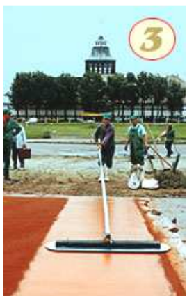
Рис.4.38. Втирание и разглаживание нанесенного отвердителя при помощи специальной стальной тёрки.
