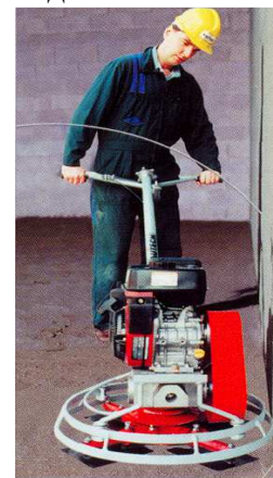
Рис. Ж.6. Затирка поверхности
