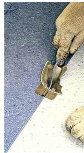
Рис.6.16. Выполнение паза между полотнищами линолеума
