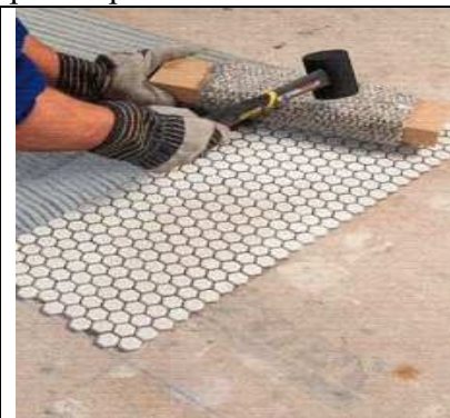
Рис.5.76. Вдавливание мозаики с помощью резинового молотка и «калатушки»
