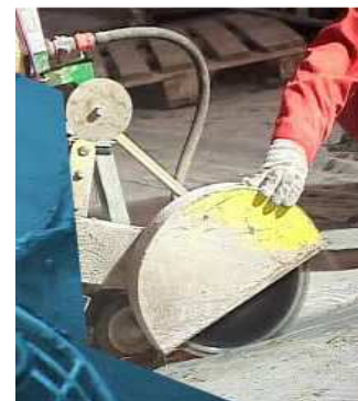
Рис.4.21. Нарезка усадочных и рабочих швов
