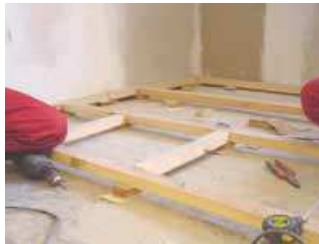
Рис. Е.9. Шаг обрешетки и ригелей должен соответствовать размерам фанеры. Ригели кладутся не реже чем 0,5м друг от друга. Но так, чтобы стыки листов фанеры были на лагах или на ригелях.
