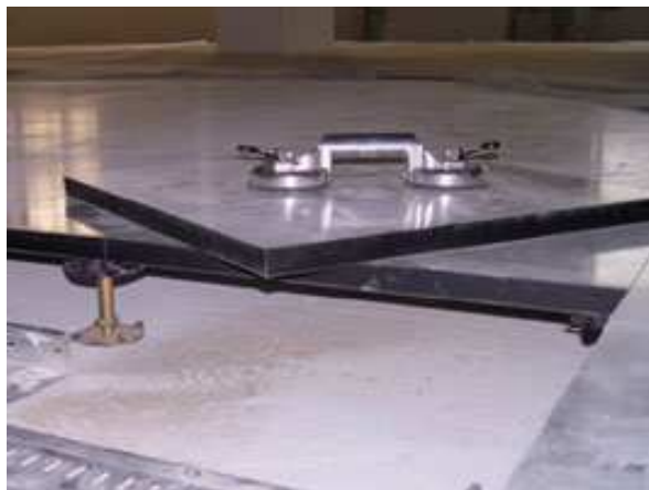
Рис.9.7. Съемник-присоска
