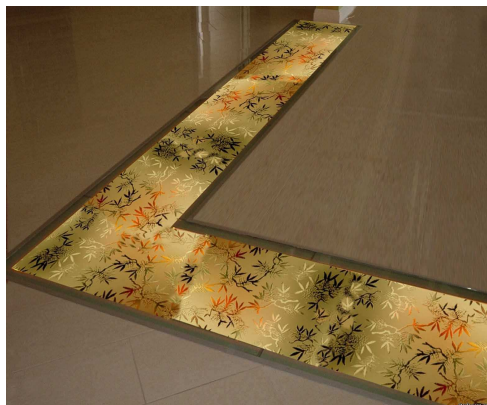
Рис. 5.78. Ленточные конструкции стеклянного пола
