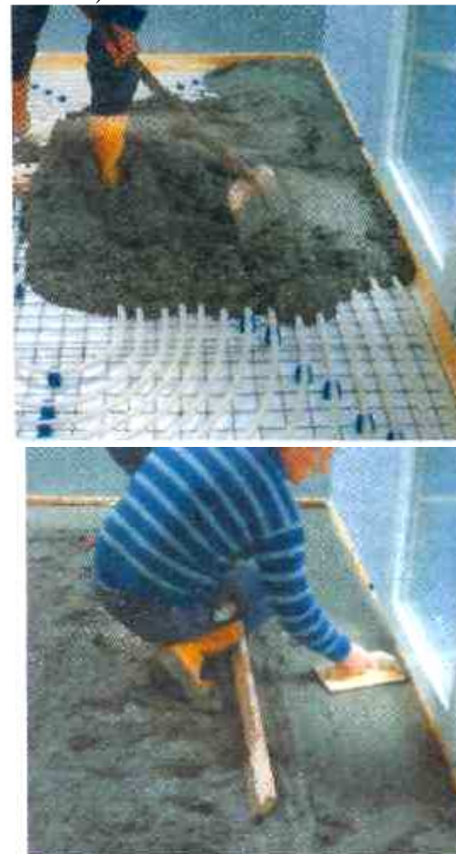
Рис.7.14. Укладка бетонной стяжки на пластиковые трубы
