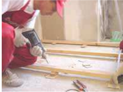
Рис.Е.7. Лаги крепятся к полу при помощи анкеров, в местах, где подложены бобышки.
