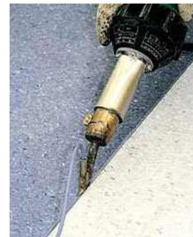
Рис.6.17. Сварка линолеума при помощи шнура
