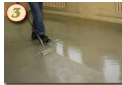
Рис.4.30. Удаление воздуха с поверхности, подготовленной для посыпки кварцевым песком
