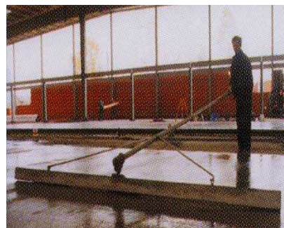
Рис. Ж.5. Втирание отвердителя стягивающей рейкой
