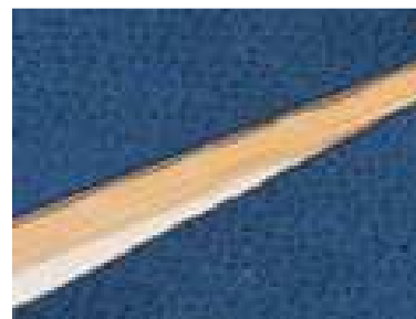
Рис.6.6. Под края двух кусков, которые нужно состыковать, подкладывают термоленту: выравнивают один край и придвигают другой
