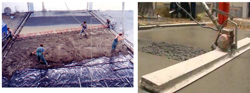
Рис. 4.17. Укладка и выравнивание бетонной смеси
