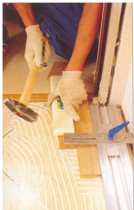
Рис.5.16. Начальный этап укладки штучного паркета с использованием установочного профиля
