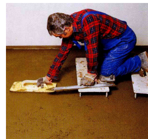
Рис.2.40. Стяжка из UZIN NC – 190
