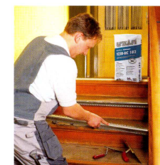
Рис.2.42. Установка рейки
