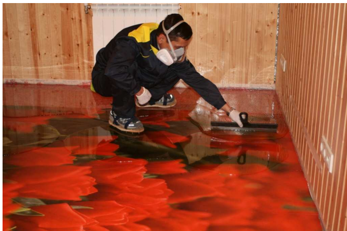
Рис.4.9. Нанесение финишного полимерного слоя на 3D изображение
