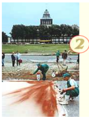
Рис.4.37. Нанесение в соответствующей пропорции цветного отвердителя PRESSBETON - MULTITOP на поверхность свежего бетона
