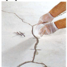
Рис.2.34. Заливка трещин смолой
