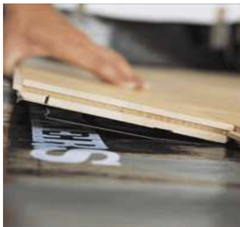
Рис. 5.52. Принцип сборки массивной доски на крепежную металлическую скобу.
