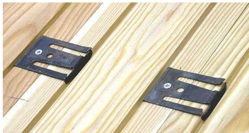
Рис. Г.5. Клевиры в рабочем состоянии с обратной стороны массивной доски
