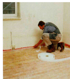
Рис.2.57. Закрывание швов
