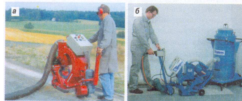
Рис.4.5. Подготовка бетонных оснований под наливные полы а-с помощью фрезерной установки; б- с помощью дробеструйной установки
