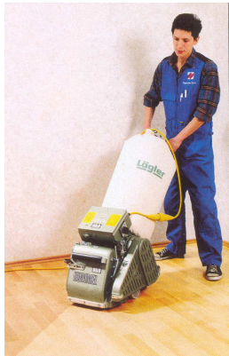
Рис.5.21. Грубая и средняя шлифовка паркета специализированными машинами
