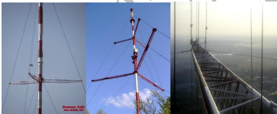
Рис. 1.8 Конструкция поперечин и несущие тросы
