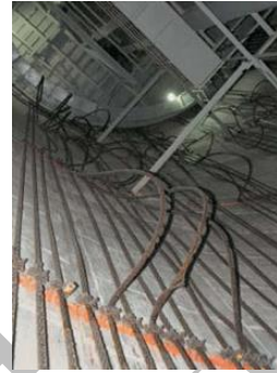
Рис. 1.20 Провисшие тросы на внутренней поверхности ствола
