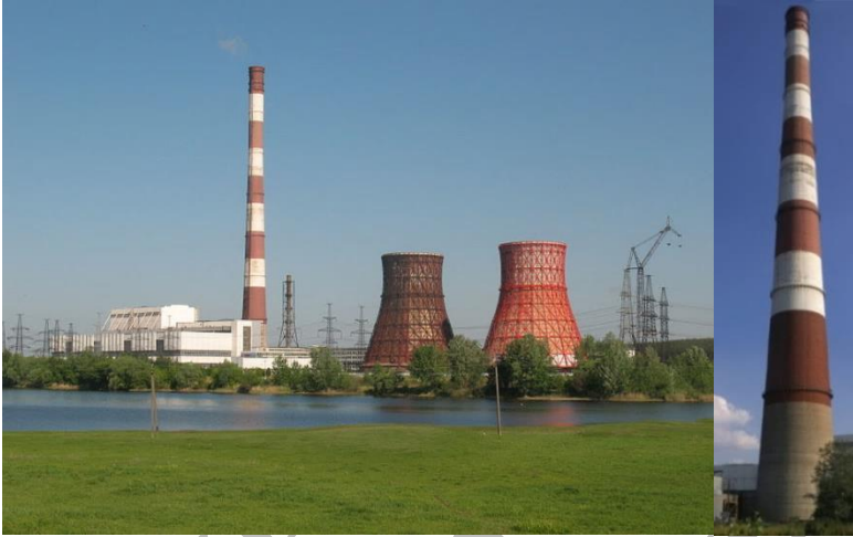
Рис. 1.9 Дымовая труба ТЭЦ-5
