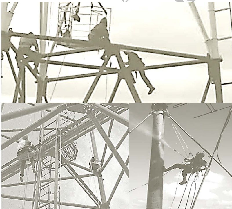
Рис. 6.14 Выполнение работ, с использованием промышленного альпинизма
