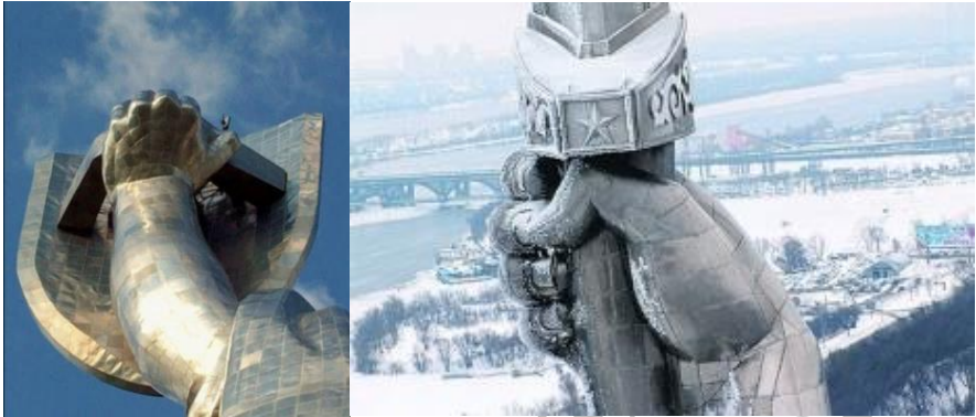
Рис. 1.15 Стальная обшивка монумента
