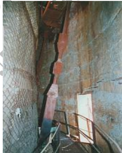
Рис. 1.10 Конструкция дымовой трубы с проходным зазором
