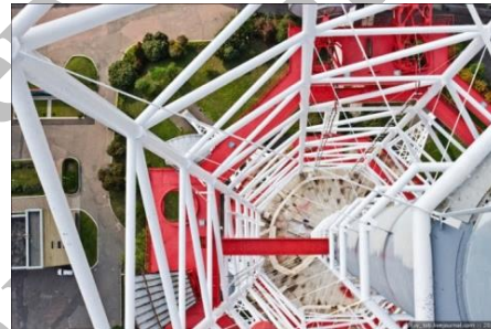
Рис. 1.5 Решетчатая конструкция башни
