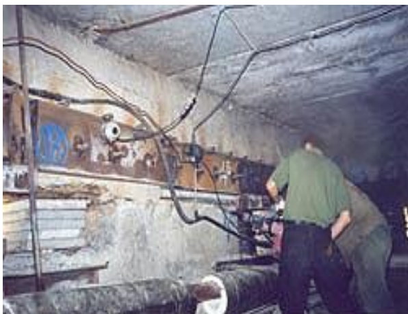
а) выпиливание ниши под установку домкратов
