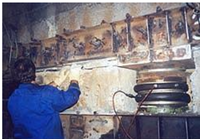
б) установка и наладка оборудования (домкраты)
