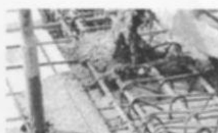
Рис. 7 – Контроль заполнения бетонной смесью нижней зоны плиты перекрытия с пустотами в виде призм пенополистирола
