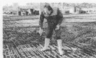
Рис. 6 – Контроль заполнения бетонной смесью нижней зоны плиты перекрытия с пустотами в виде перевернутых колпаков
