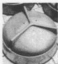
Рис. 6 – Контроль заполнения бетонной смесью нижней зоны плиты перекрытия с пустотами в виде перевернутых колпаков
