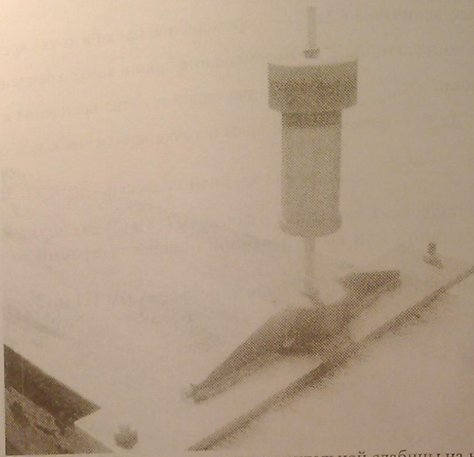
Рис.6. Установка узла предварительной слабины на конструкции
