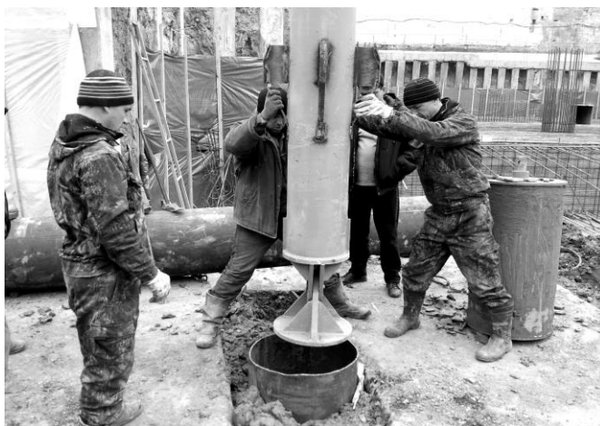
Рис. 1. Опускание штампа и колонны труб в скважину на площадке №1
