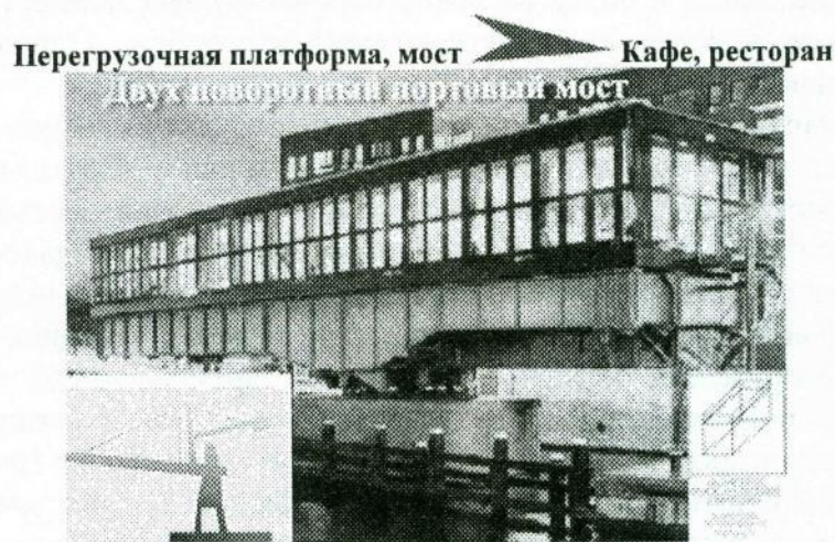
Рис. 2. Приспособление двухповоротного моста 1922 г. постройки под кафе. Амстердам
