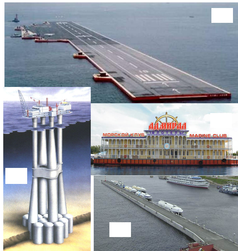
Рис.1. Примеры плавучих железобетонных сооружений. а - аэропорт в Японии, б - нефтедобывающая платформа, в - отель, г - причал
