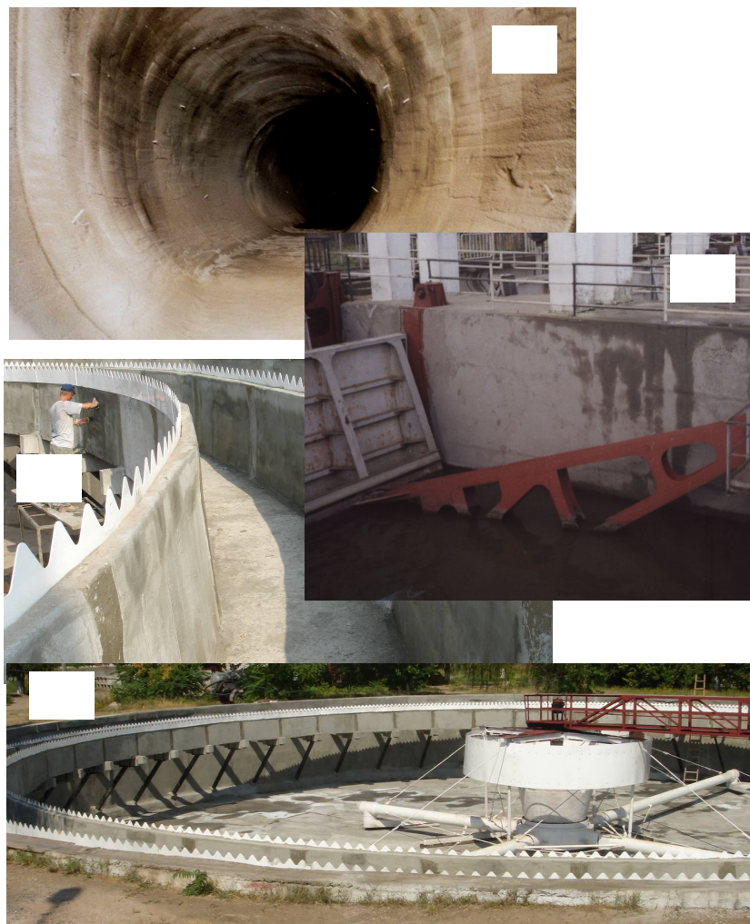
Рис.6. Применение разработанных модифицированных бетонов и фибробетонов на объектах водно-хозяйственного назначения. а – гидротехнический тоннель канала Днепр-Донбасс, б – входной оголовок главного шлюза канала Дунай – Сасык, в,г – очистные сооружения Николаевского водоканала
