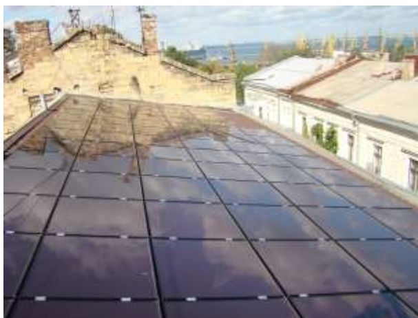
Рис.1. Солнечная термофотоэлектрическая система на крыше в Одессе площадью 80 м 2 .
