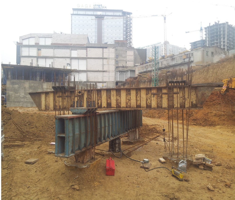
Рис. 3. Фрагмент испытания известняка буронабивной сваей.
