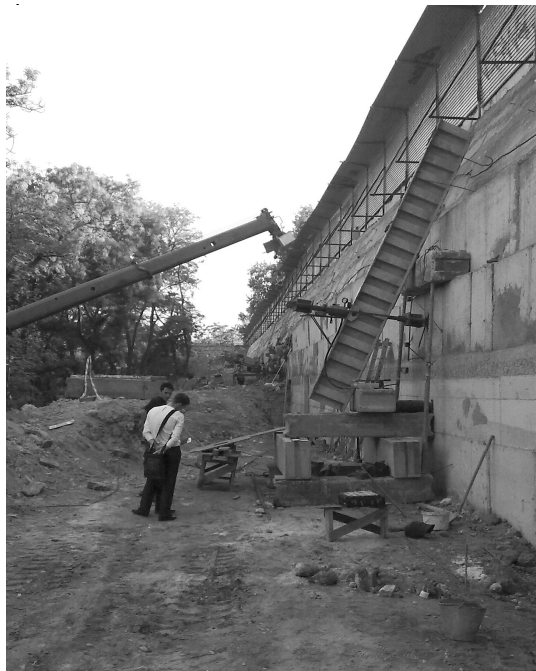
Рис. 2.15. Общий вид оборудования при испытании сваи-анкера на выдергивание
