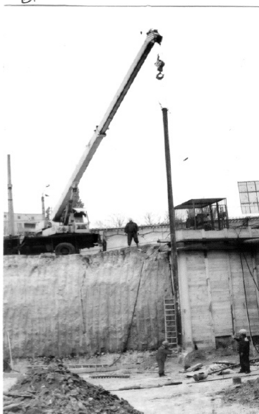
Рис. 2.9. Подготовка испытаний опытными штампами: а) бурение скважин для установки штампов; б, в) монтаж штампов-стоек в скважины на участках I и II по ул. Генуэзской, 1
