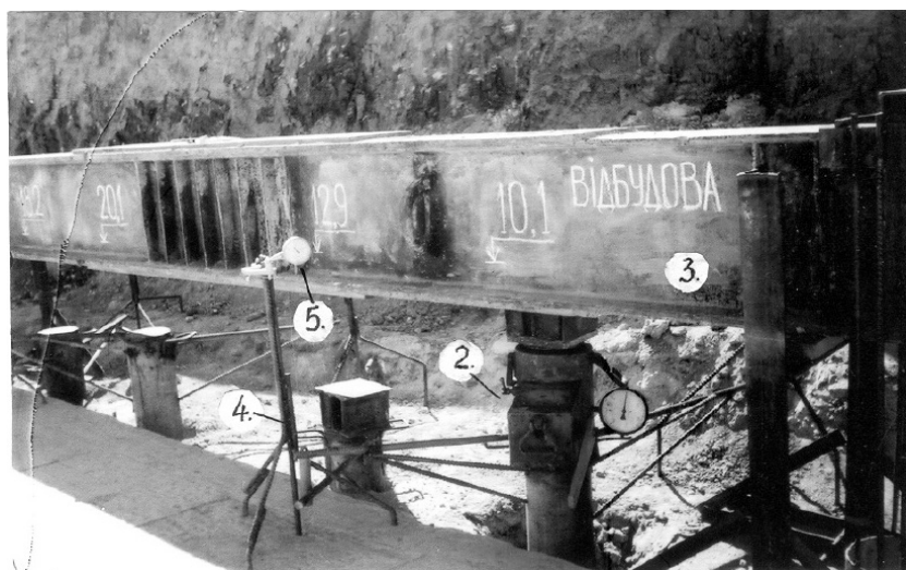
Рис. 4.8. Общий вид испытательного комплекса: 1 — штампы-стойки; 2 — домкрат ДГ-100; 3 — опорная балка; 4 — реперная система; 5 — прогибомер 6 ПАО; 6 — анкерная свая
