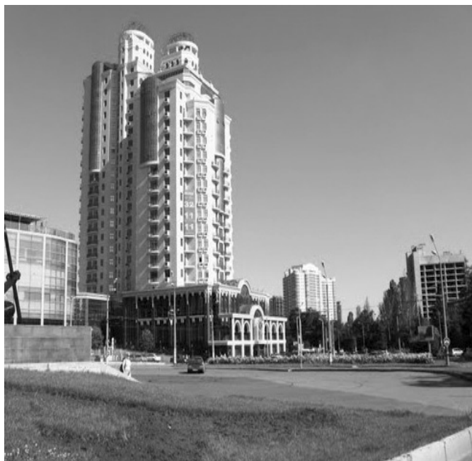
Рис. 4.10. Высотные здания по ул. Генуэзской, 1 в г. Одессе
