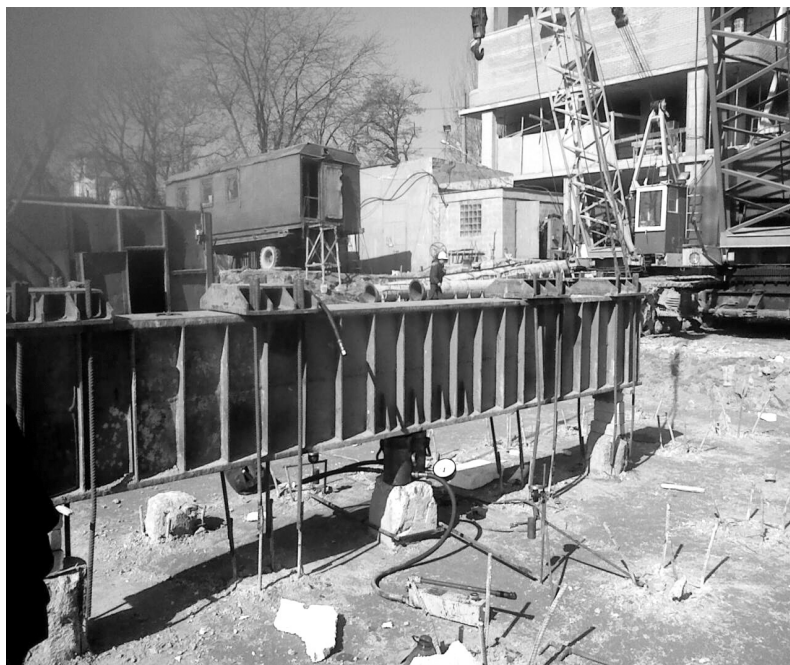
Рис. 2.11. Фотоснимок испытаний грунтов натурными сваями на вертикальную вдавливающую нагрузку
