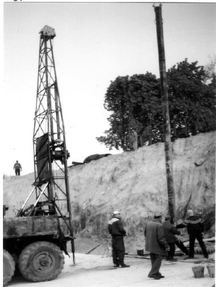
Рис. 2.9. Подготовка испытаний опытными штампами: а) бурение скважин для установки штампов; б, в) монтаж штампов-стоек в скважины на участках I и II по ул. Генуэзской, 1
