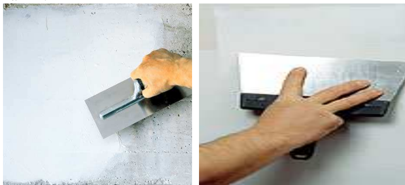
Рис. 1.4. Характерный внешний вид бетонной поверхности перед отделкой и после наложения соответствующей шпатлевки
