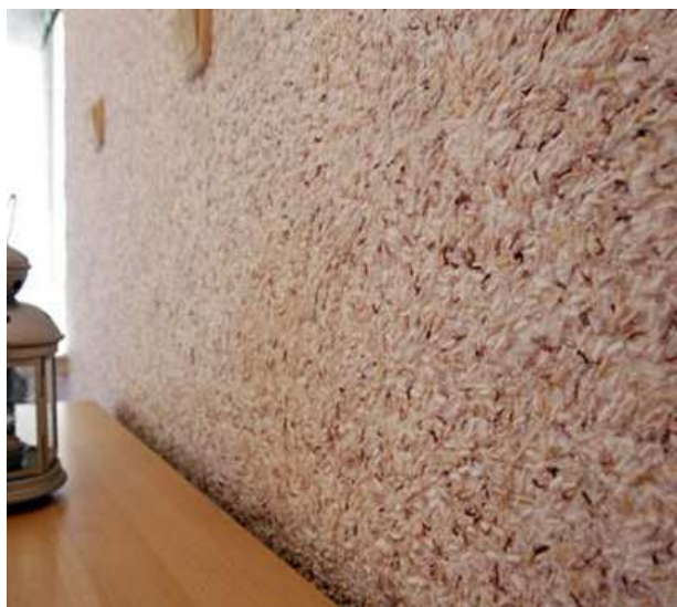
Рис. 1.11. Покрытие из "жидких обоев"
