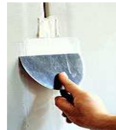
Рис. 1.8. Заделка стыков гипсовых панелей (листов) высокопрочной шпатлевкой без применением уплотнительной (армирующей) ленты
