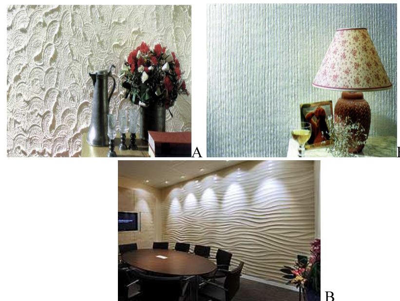
Рис. 1.9. Использование мелкозернистой штукатурки для различного моделирования поверхности (CAPAROL): А - структура «кружочки»; Б - структура «бороздки»; В - структура «волны»
