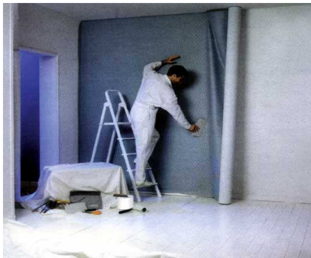
Рис. 1.43. Монтаж бесшовных тканевых стеновых покрытий (СТРИНГЕР)
