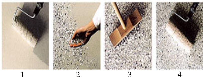
Рис. 1.14. Техника нанесения «флока»: 1 – нанесение клеящего слоя; 2–3 – нанесение акриловых частичек; 4 – нанесение слоя лака
