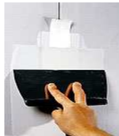
Рис. 1.7. Заделка стыков гипсовых панелей с применением уплотнительной (армирующей) бумажной ленты
