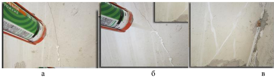
Рис. 3. Фрагменты заделки мелких трещин «паутинок»:
