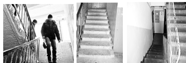
Рис. 10. Вид стін всередині під'їзду до і після ремонту та утеплення
