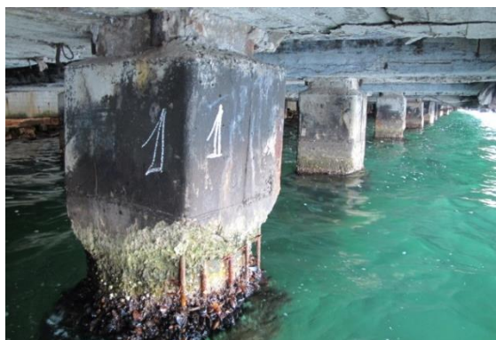
Рис. 3. Повреждения свайного основания
