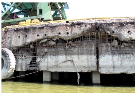
Рис. 2. Состояние бортовой балки
