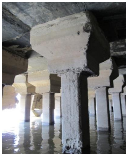
Рис. 1. Состояние сваи и наголовника
