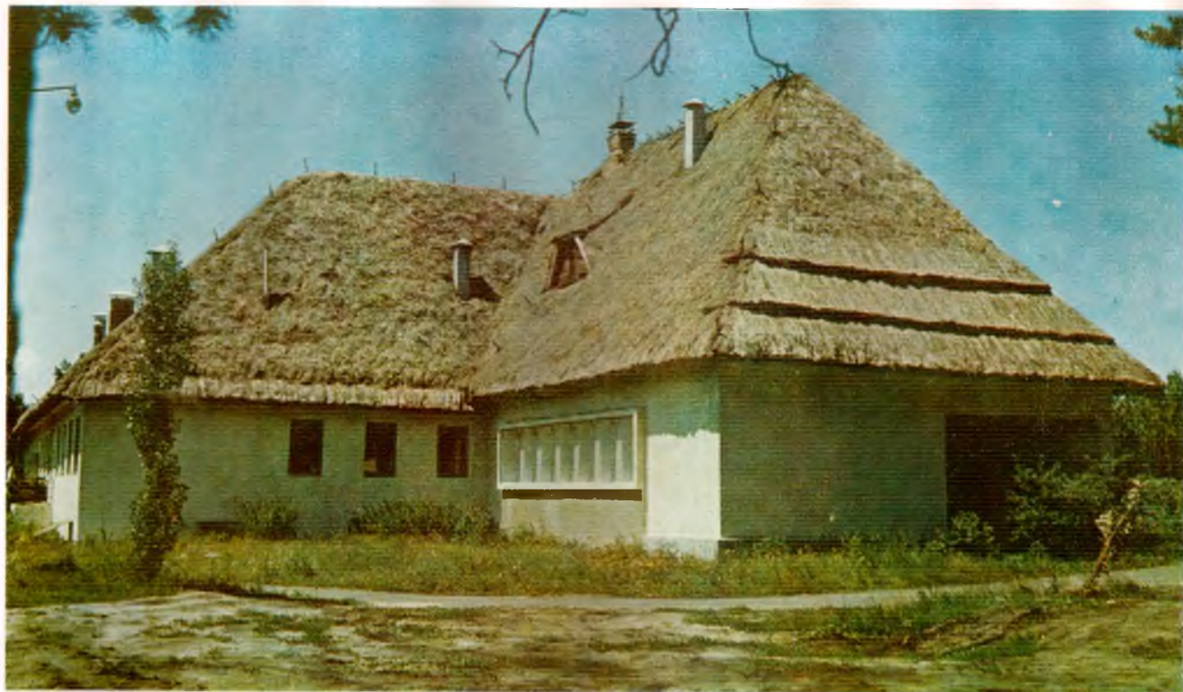
Ресторан «Наталка» на окраине Киева. Общий вид.
