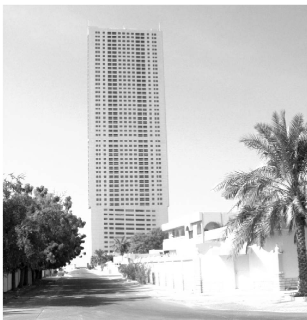
Рис.4. Многоуровневая автостоянка, на первых 12 этажах высотного жилого здания в г. Шарджа ОАЭ
